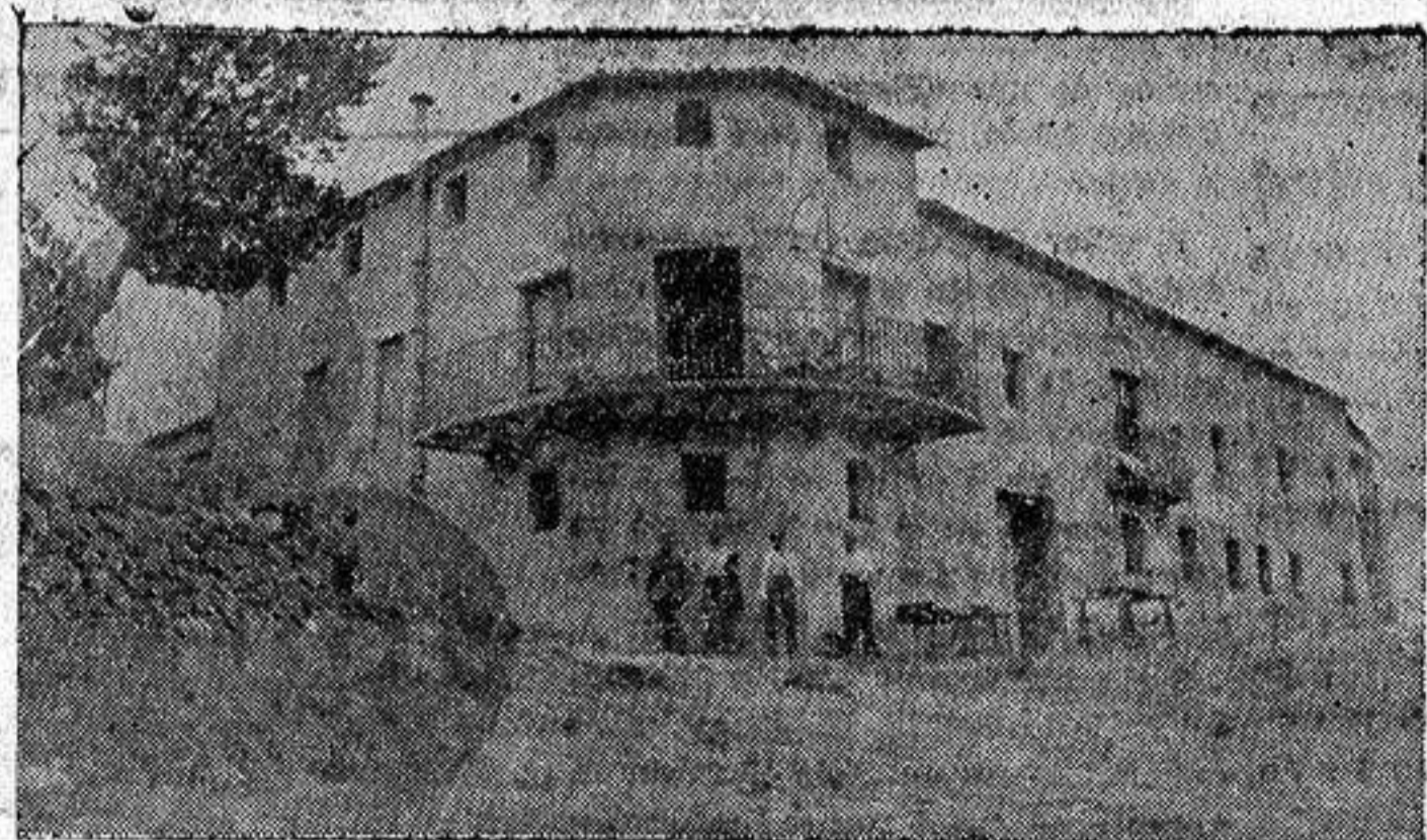
Edificio «Vistahermosa», situado a 900 metros de altitud sobre el nivel del mar y que ocupa la Colonia escolar de vacaciones de la Diputación, emplazado frente a la ermita de Polop de Alcoy
