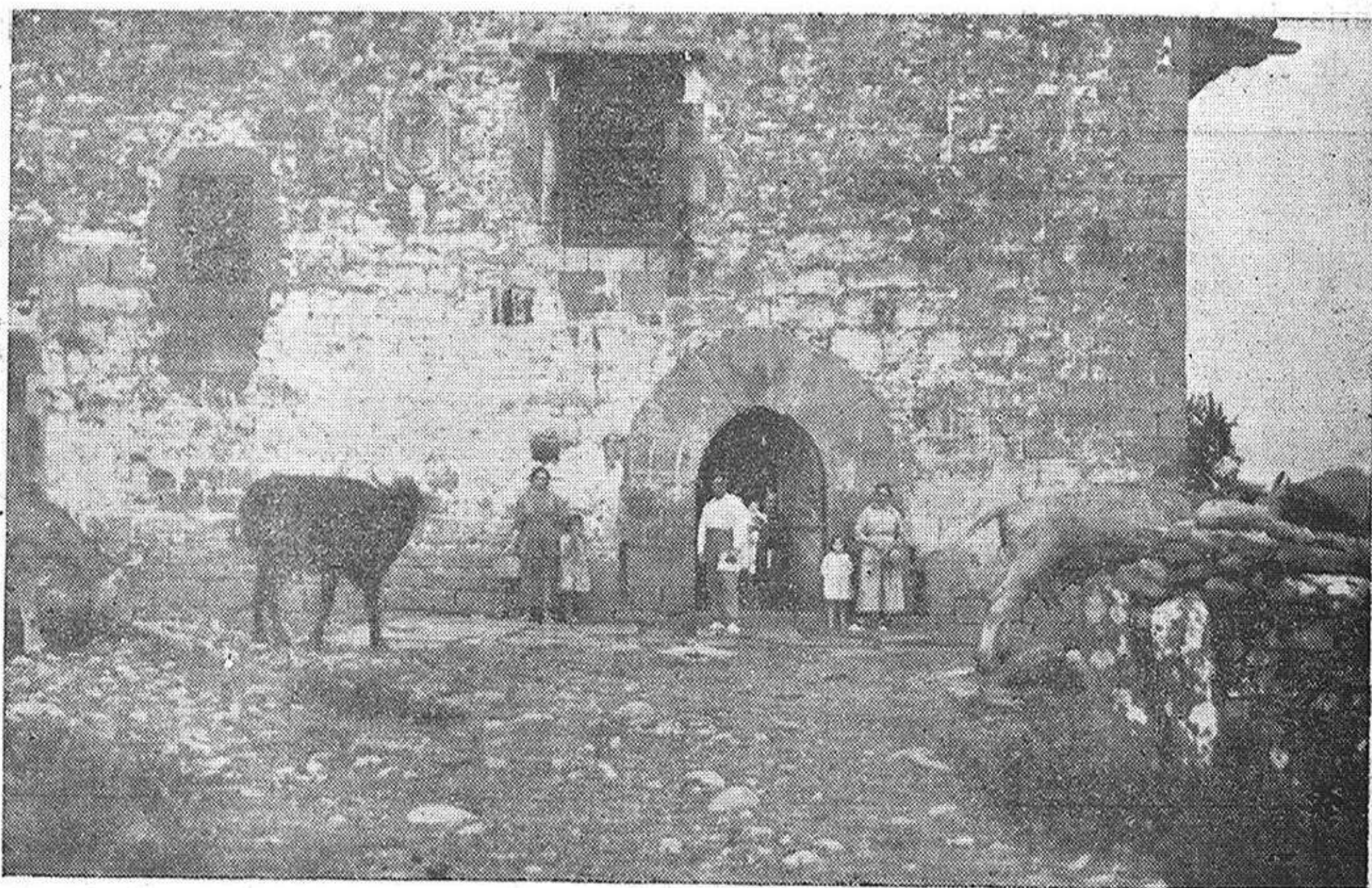
PALACIO ZUBIRA. — Fachada Oeste.
