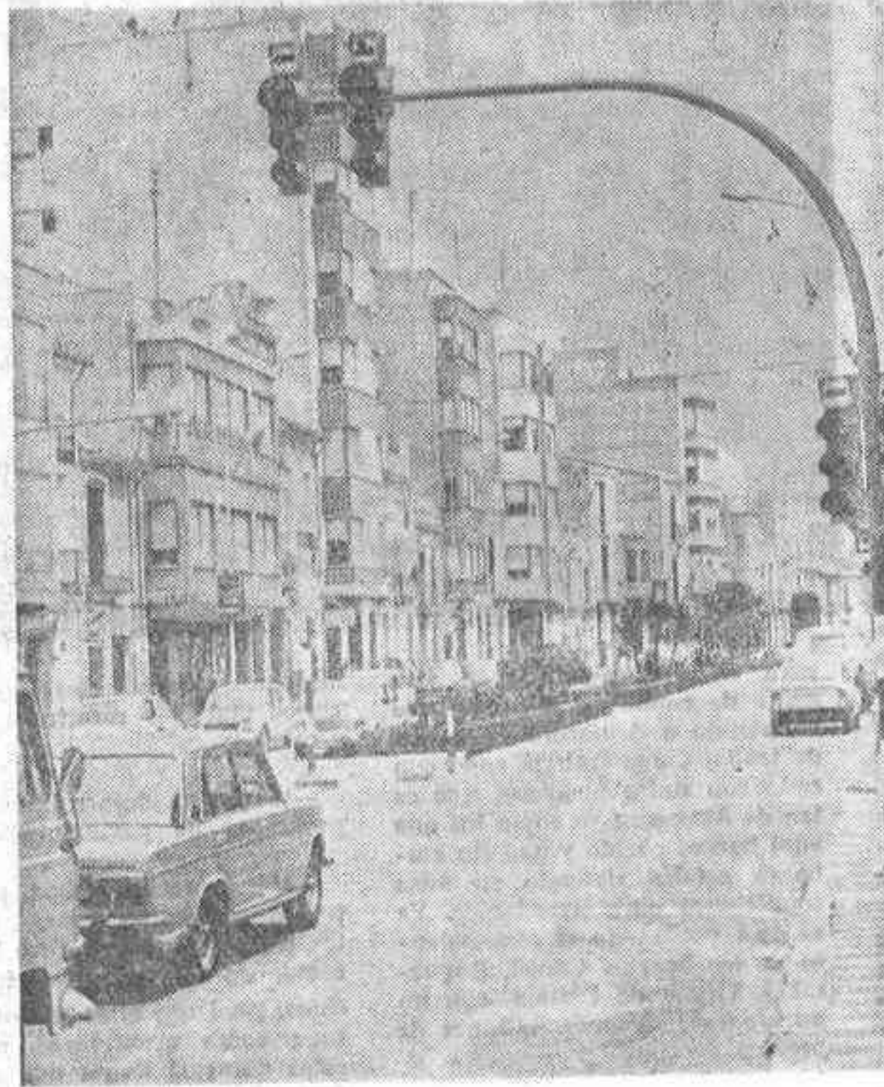
Nuevos semáforos en el centro de Almazora
