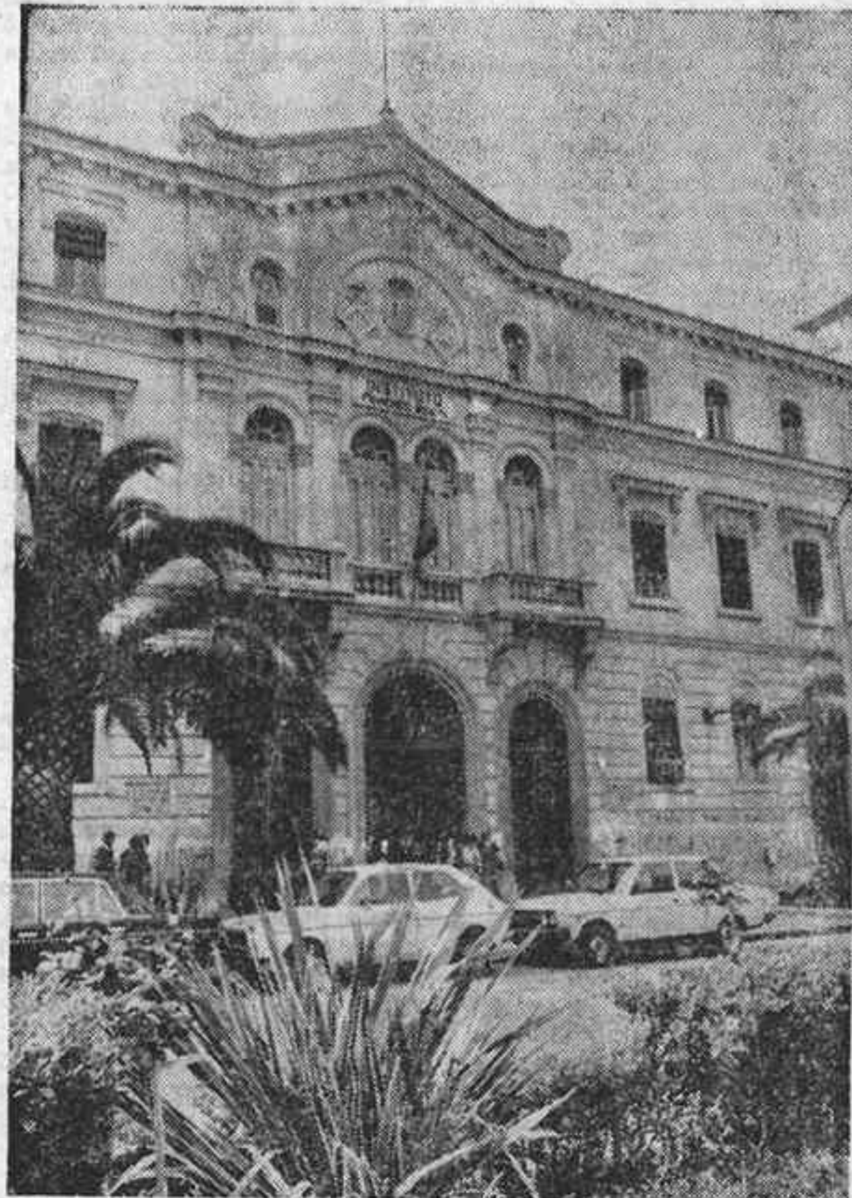
Nueve millones de pesetas se invertirán en reparar el Instituto "Francisco Ribalta".
