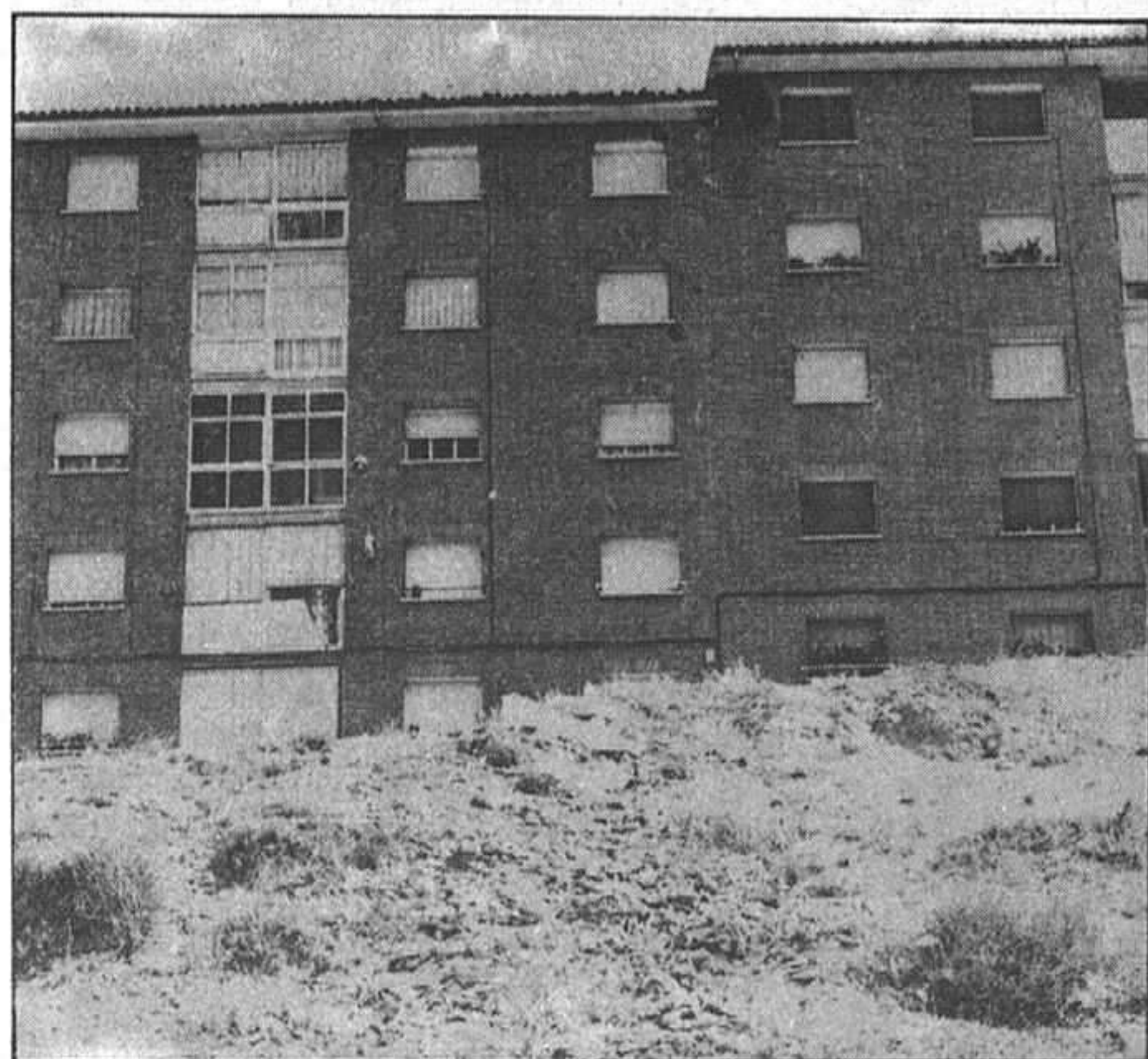
EL ALAMIN Y EL CENTRO DE SALUD. En el barrio del Alamin, el barrio olvidado y marginado como se decía antes, está previsto la ubicación de un Centro de Salud en un local cedido por la Fundación General Mediterránea y el presupuesto para realizar las obras de acondicionamiento precisas asciende a unas 200.000 pesetas. Según informó en su día el Ayuntamiento, el equipo para estos centros, incluida la instalación de un aparato ecográfico, importará unos nueve millones de pesetas y el presupuesto total, de 10 millones, será aportado por la Junta de Comunidades de Castilla - La Mancha. Las críticas a estos centros de salud, por parte de profesionales de la medicina, no se ha hecho esperar y es fácil que en breve se conozca por la opinión pública.
