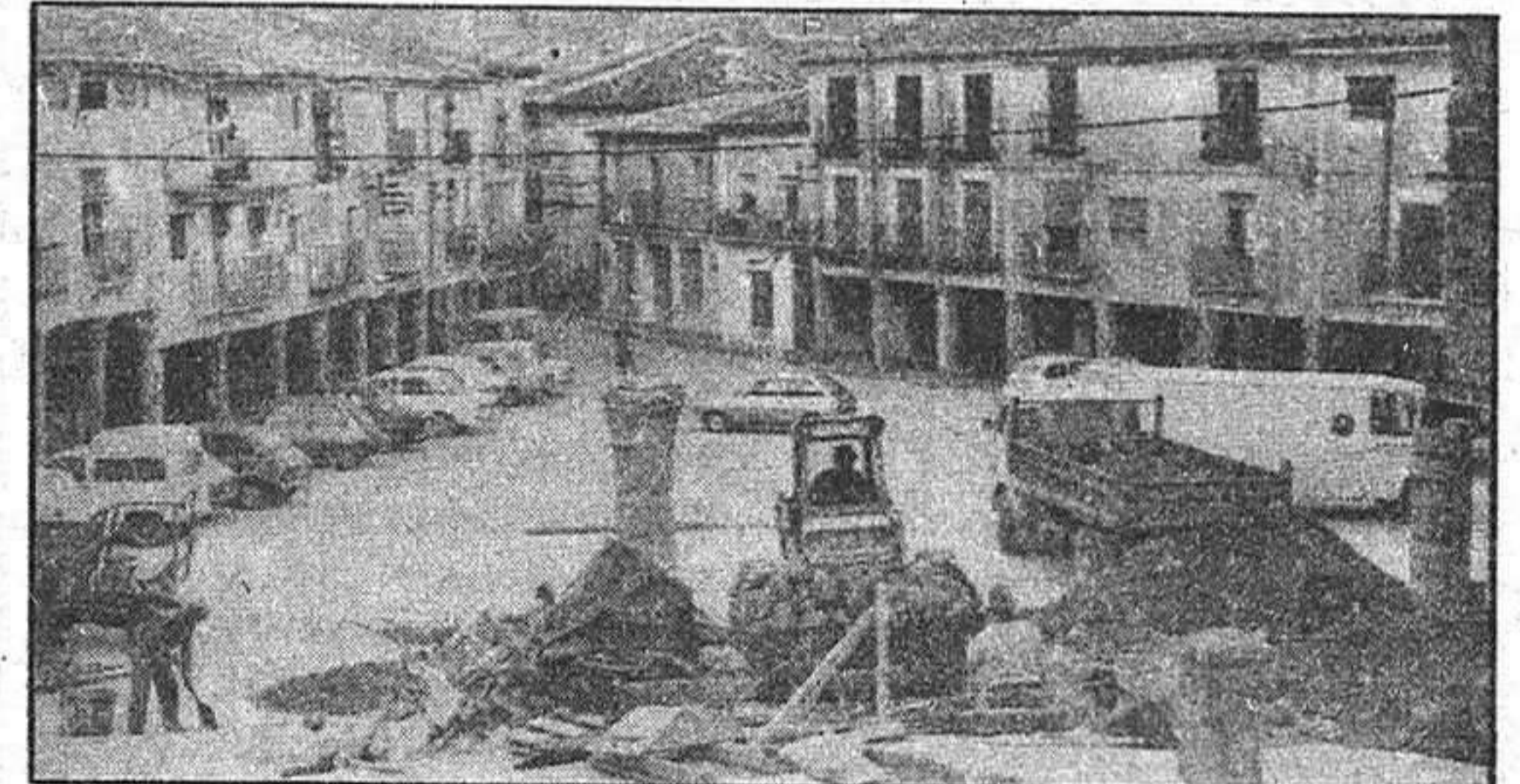
Las obras en Cifuentes están a la orden del día, mientras el pueblo cambia su fisonomía.
