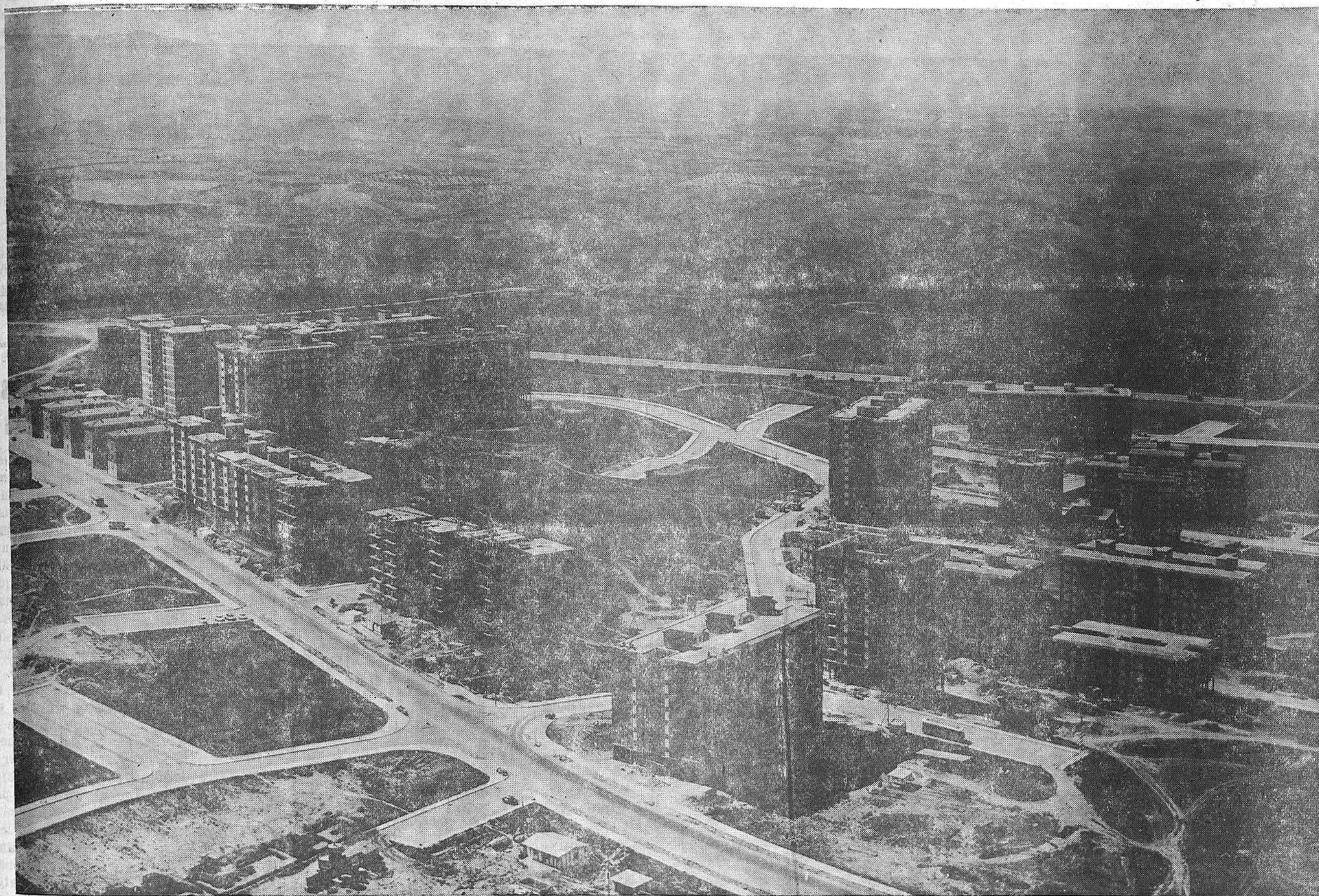
CONSTRUCCION DE 1.309 VIVIENDAS, ACOGIDAS A LA LEY DE RENTA LIMITADA, SUBVENCIONADAS, EN EL POLIGONO «EL BALCONCILLO» (GUADALAJARA)
