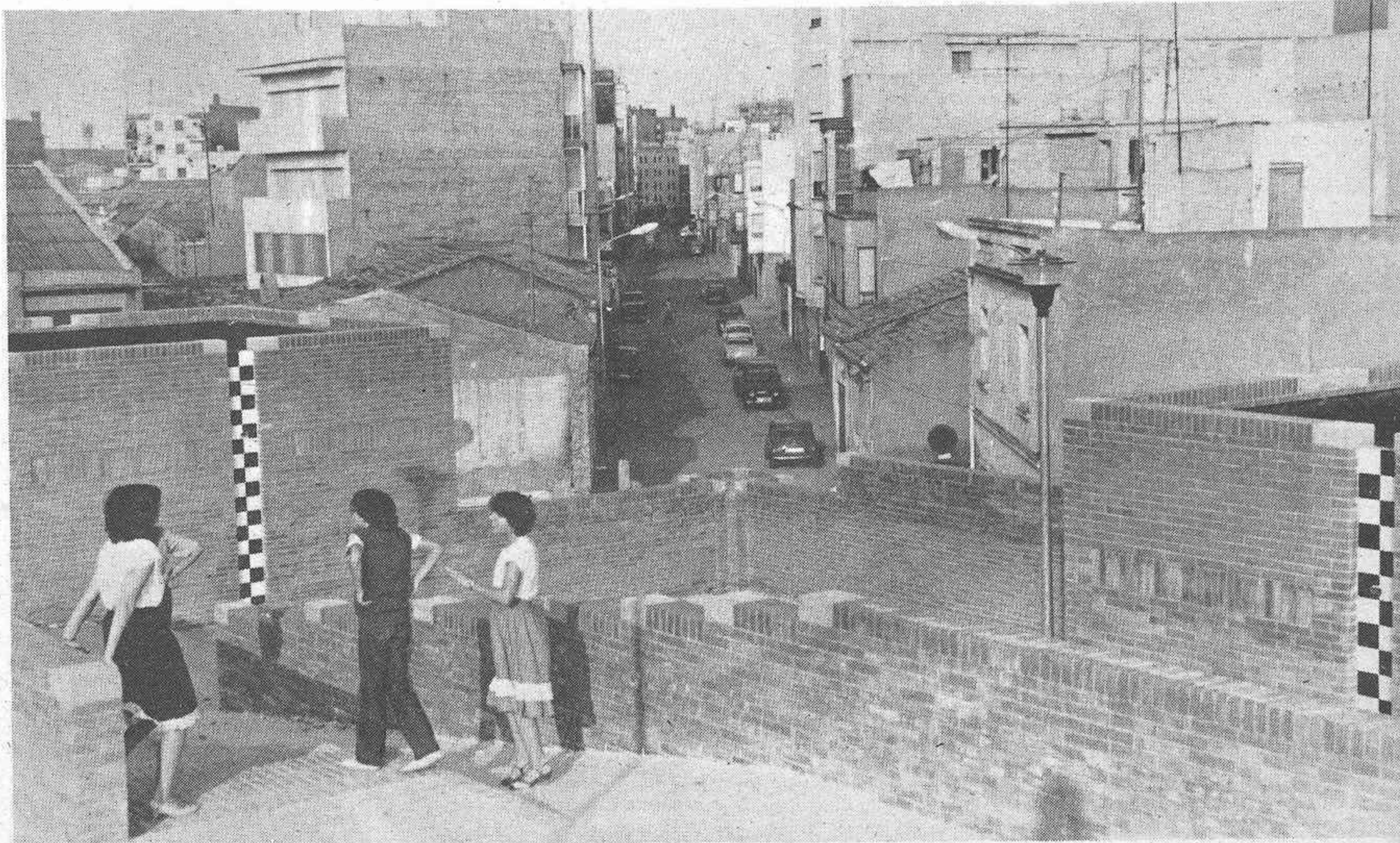
La calle cerrada por los muros del jardín
