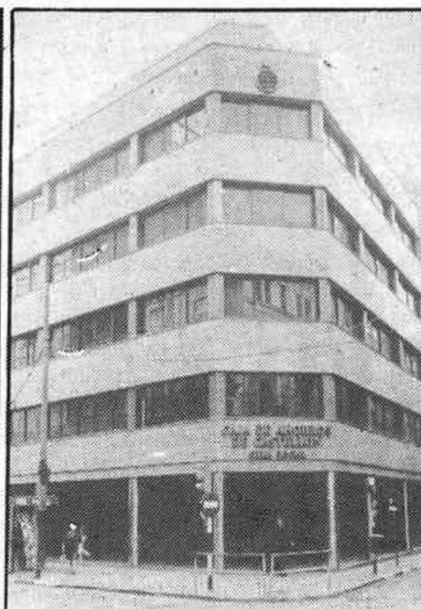
Caja de Ahorros y Monte de Piedad de Castellón
