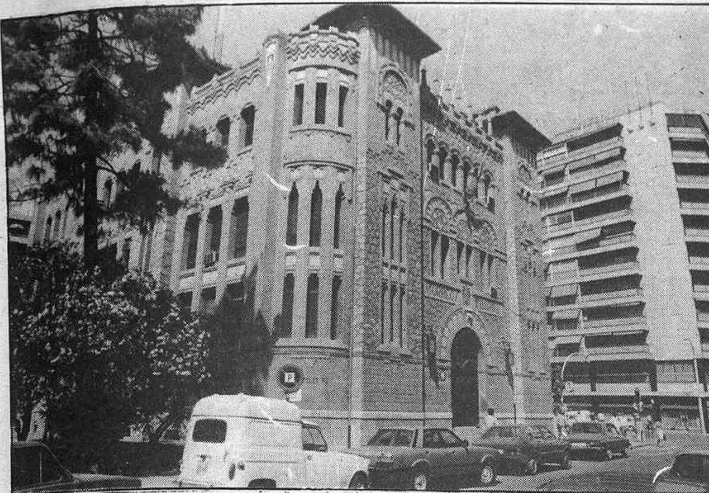
Cerca de 100 millones se invertirán en obras de mejora
