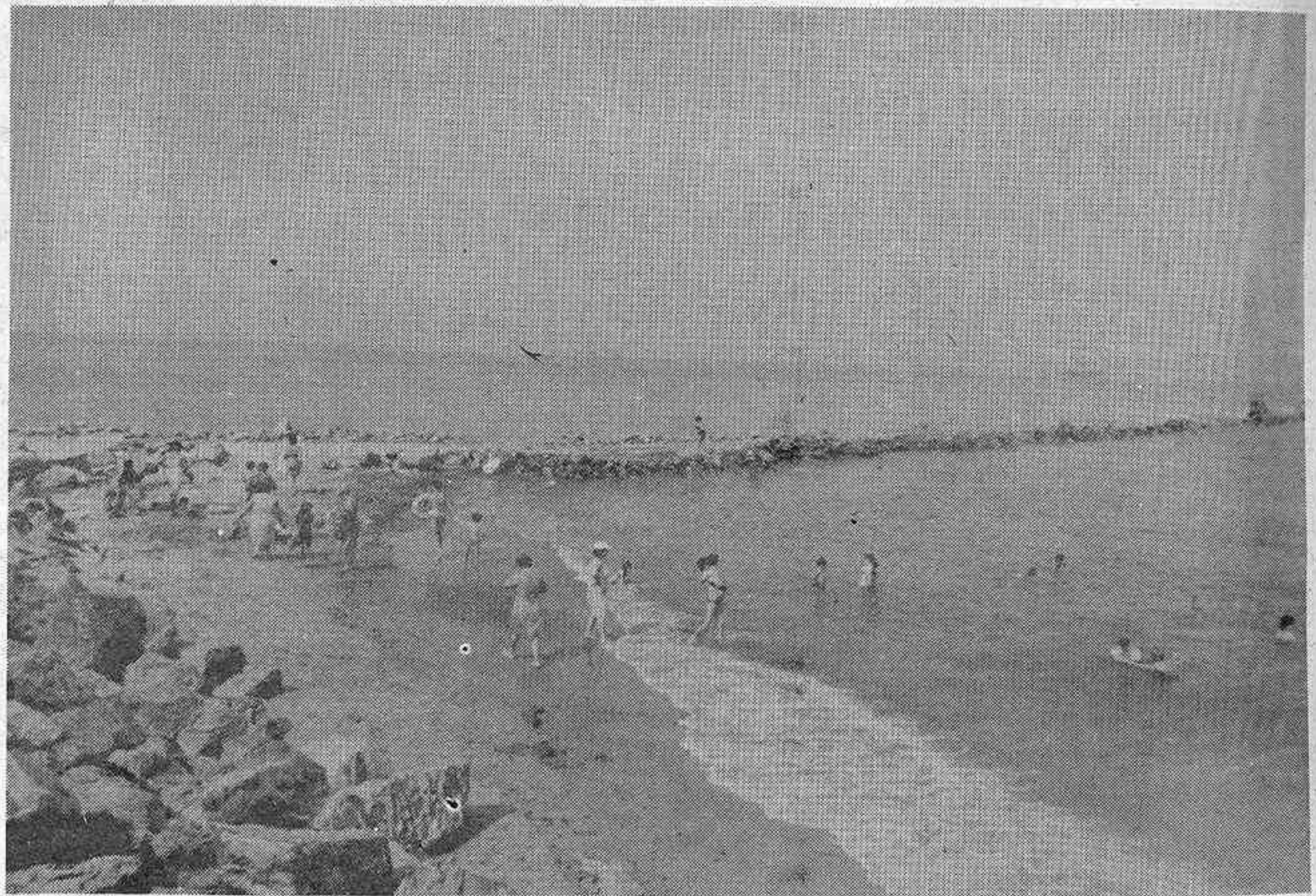
Las obras de la primera fase de espigones, a cargo de la Dirección General de Puertos y Costas, se están realizando a ritmo óptimo
