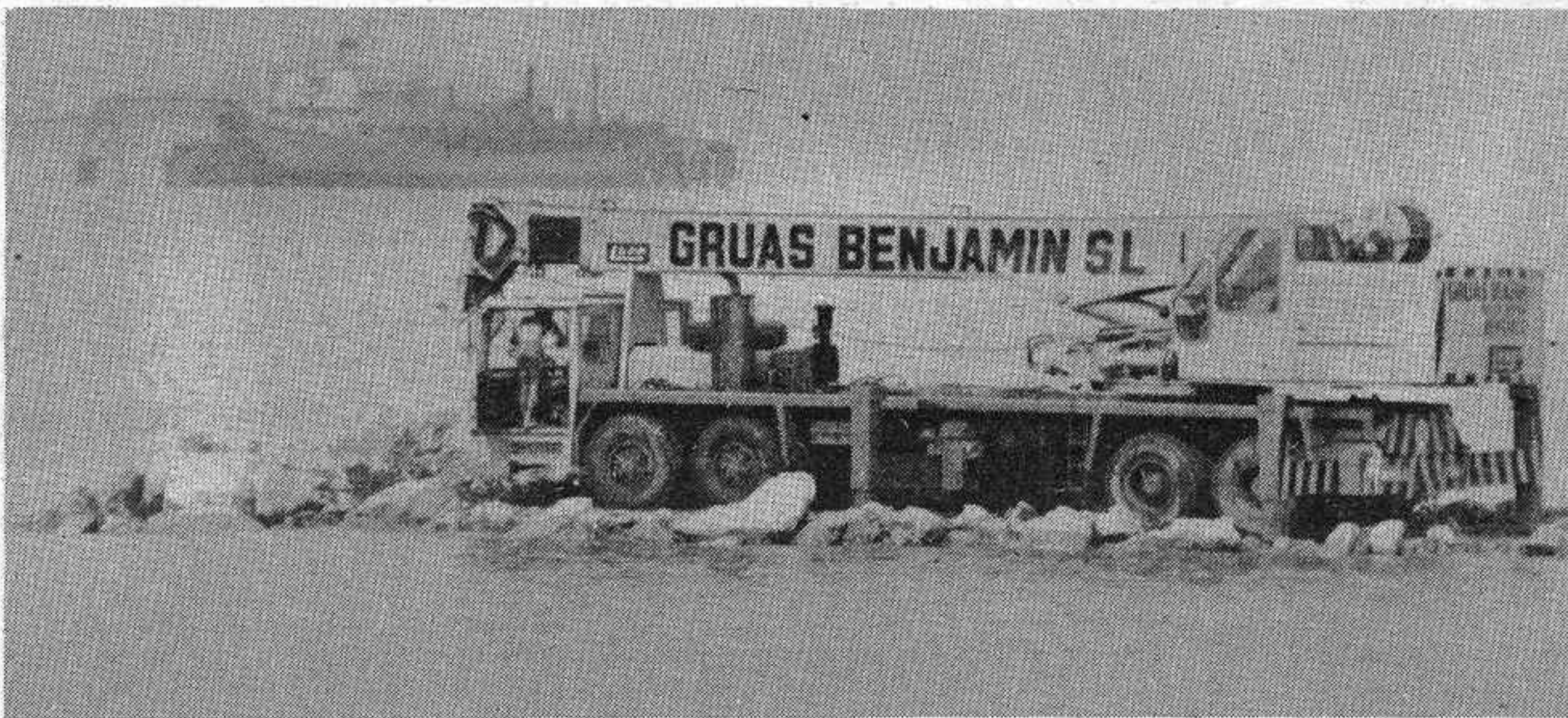
Un camión-grúa trabajando en el extremo final de un espigón
