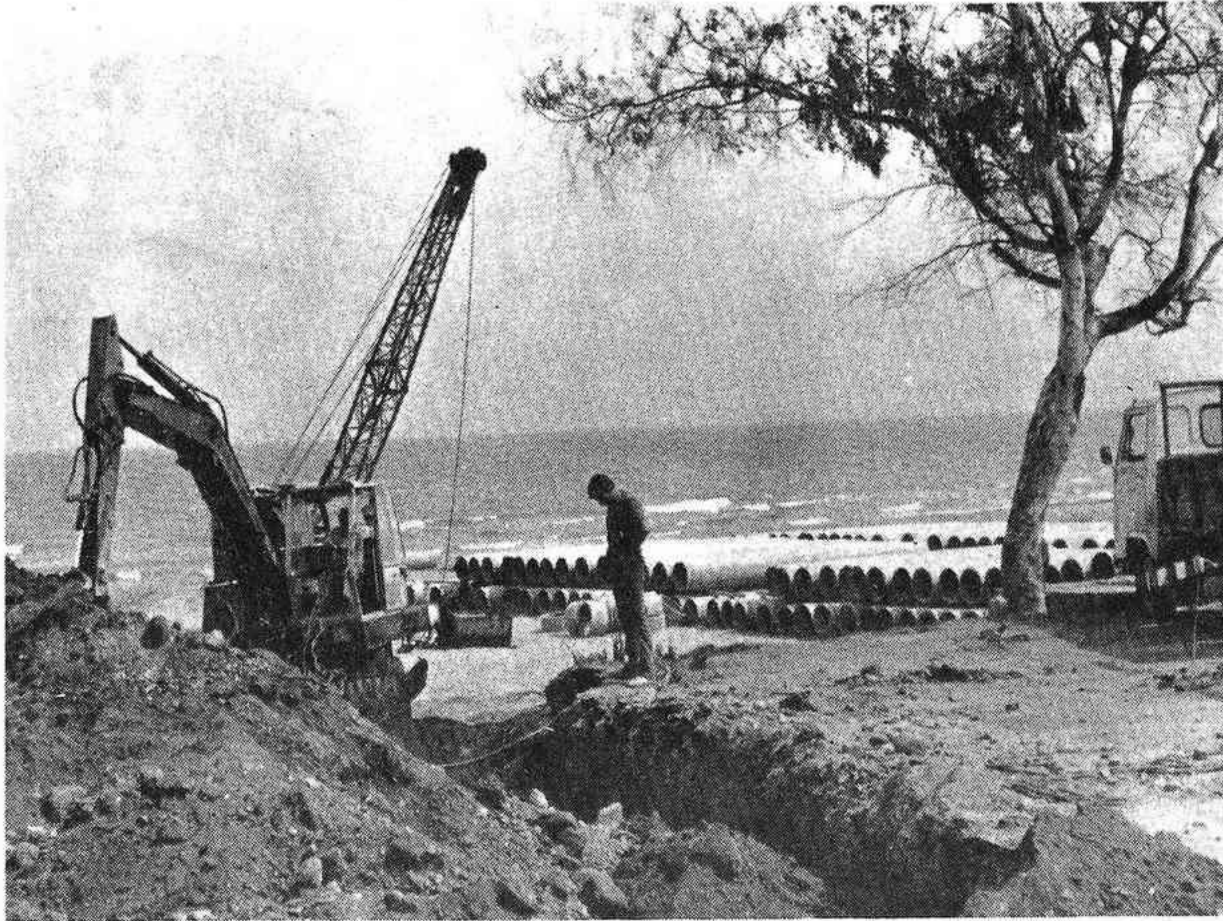
Obras del colector submarino, contruido el año pasado. Sin la depuradora, el colector servirá de poco.
