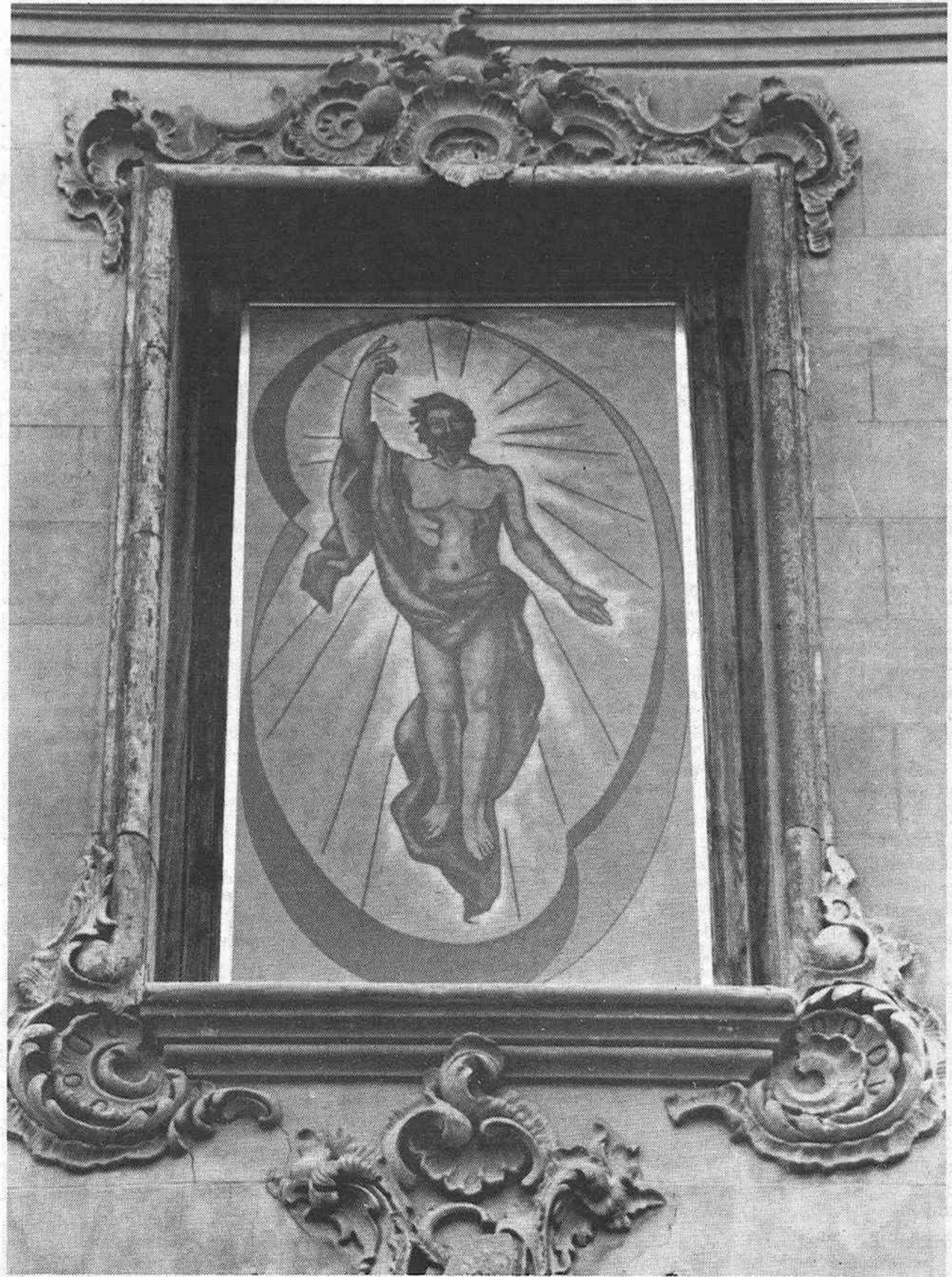
Entre las elegantes rocallas que enmarcan el ventanal, se ha colocado una vidriera de pésimo gusto.
