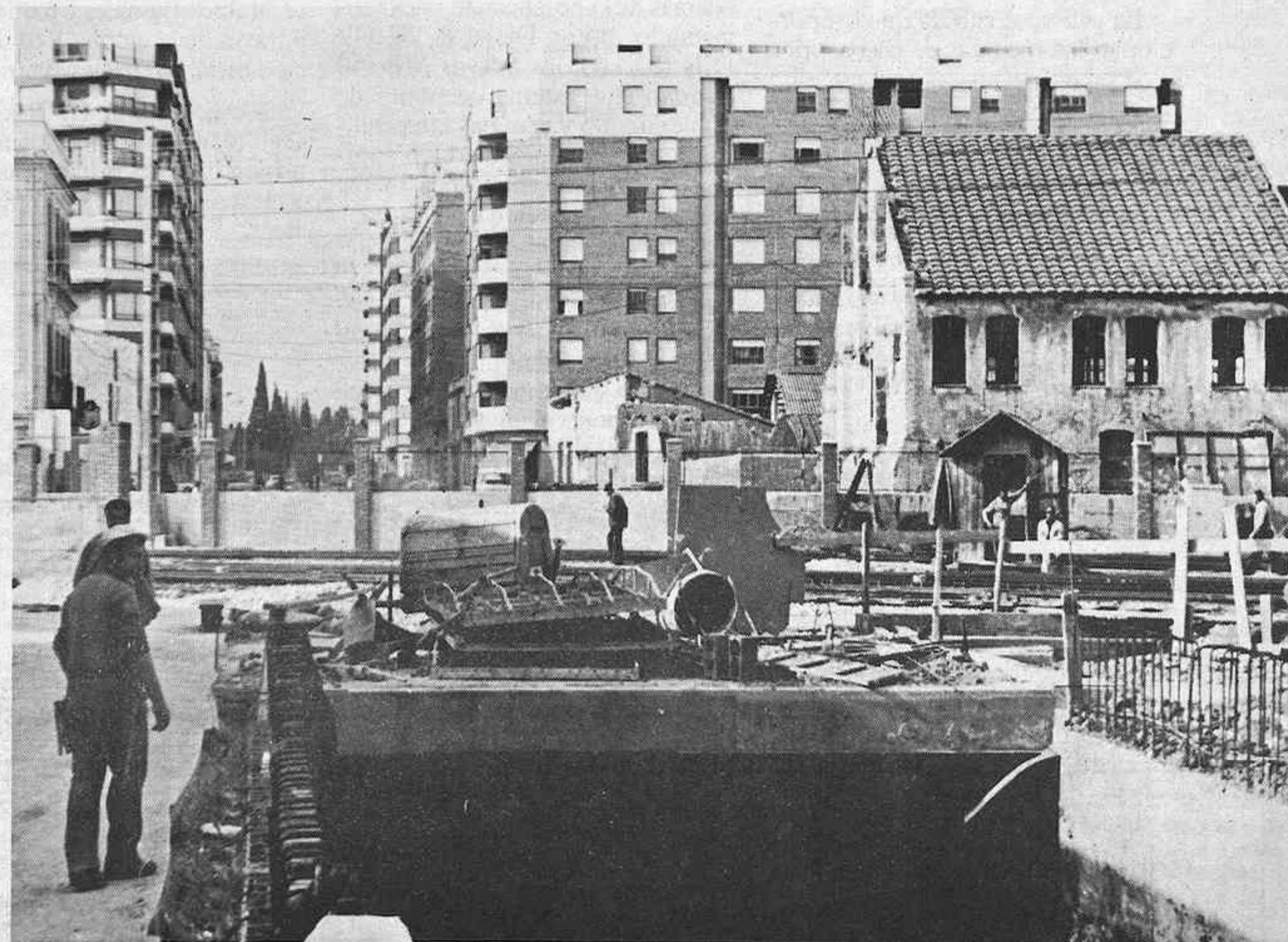
La parte superior del paso quedará cortada a la circulación
