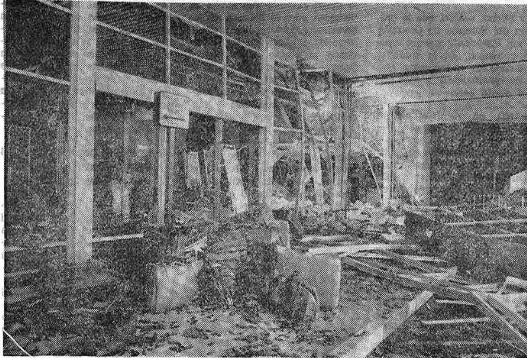
En la foto, destrozos en el aeropuerto Madrid-Barajas tras la explosión de la bomba. — (Foto EFE)
