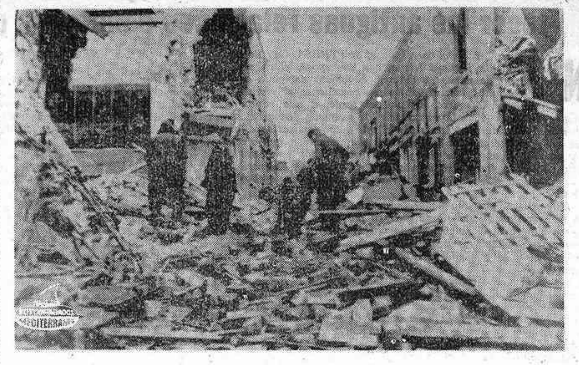
BELFAST.— La capital del Ulster se asemeja a diario más a una ciudad en guerra que a otra cosa. Las bombas que estallan en vehículos abandonados, continúan aumentando el número de víctimas, en tanto que los explosivos colocados en edificios convierten a éstos en ruinas. La foto capta las ruinas ocasionadas por una reciente explosión en el centro de Belfast.— (Telefoto Cifra Gráfica).
