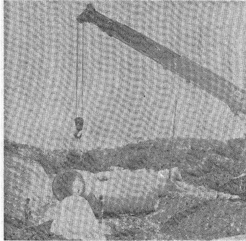
Grúa Grave TM 800, colocando tuberías de 170 de diámetro y 9.000 kg. de peso. Compárese su tamaño con el de las personas. (Foto Gonzalo Puerto)
