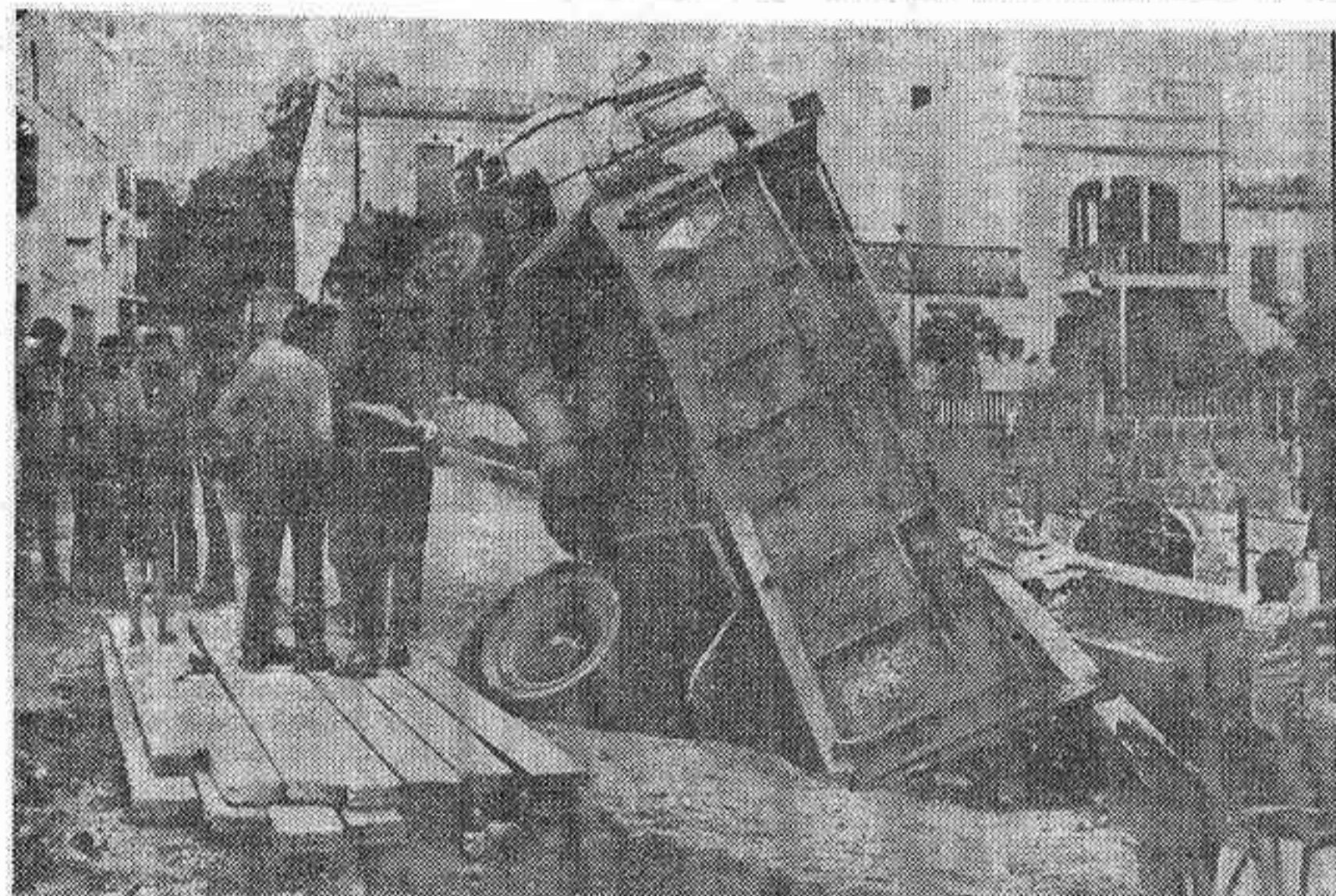
CALELLA DE PALAFRUGELL (Gerona).— En esta difícil postura quedó este camión cargado de gravilla...
