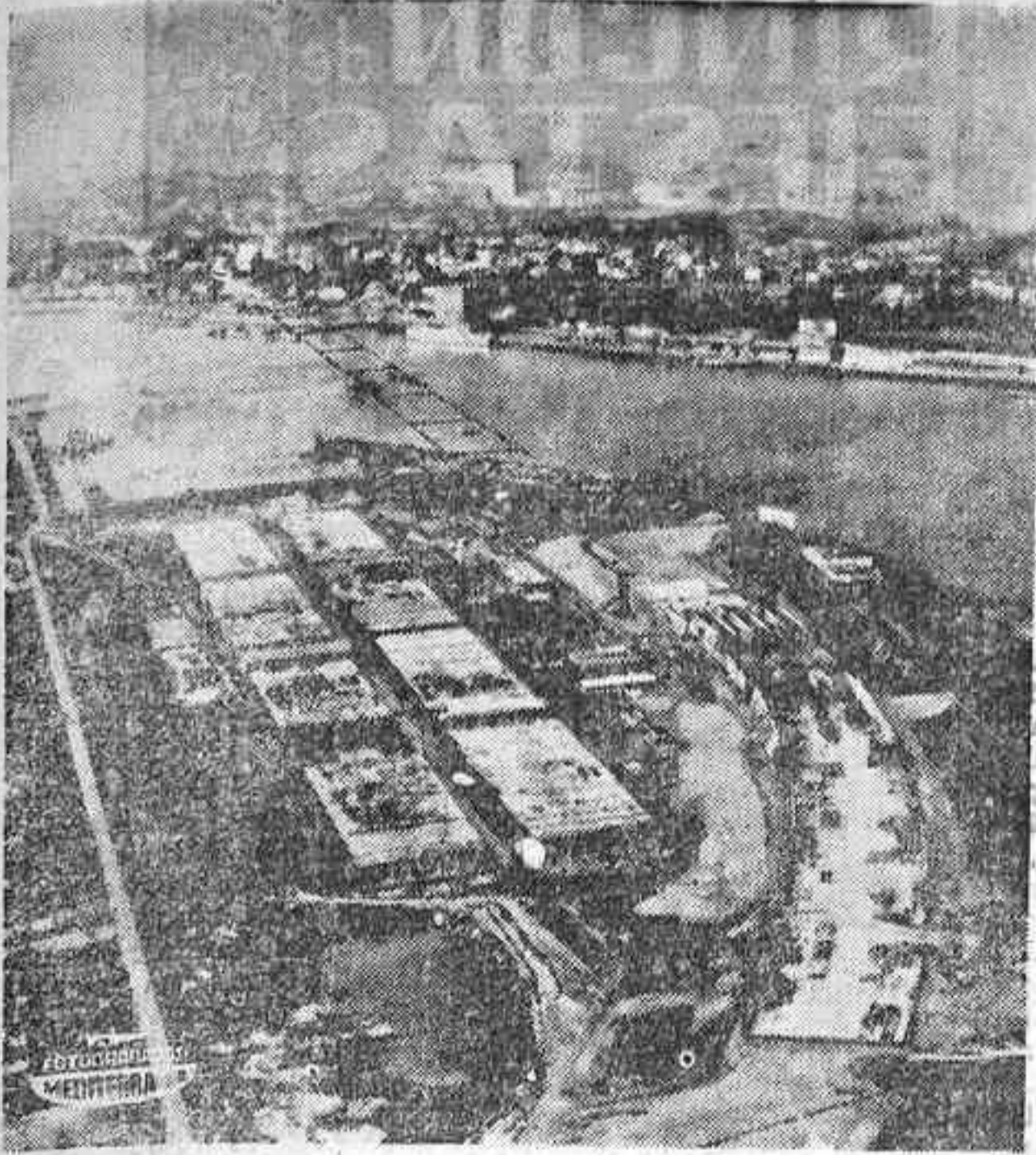
Los 8 elementos prefabricados que serán sumergidos en el lecho del Elba. Obsérvese las tres autopistas y los dos conductos de purificación del aire que hay en su interior.
