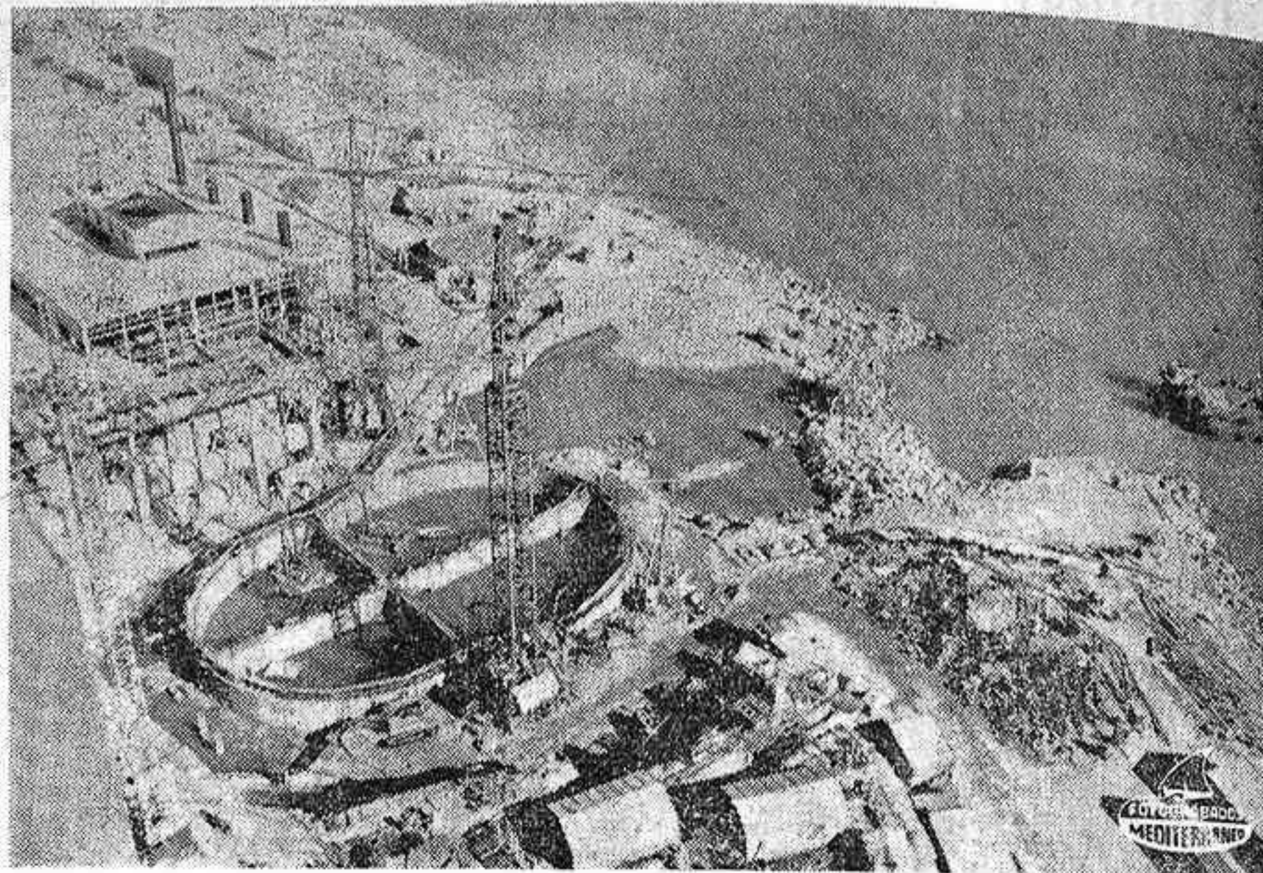
VANDELLOS. — He aquí una vista de la central nuclear de Vandellós, donde se ha llevado a cabo la colocación de la enorme tapadera que cubre el reactor de dicha central. La tapadera en cuestión, de 600 toneladas de peso, 25 metros de diámetro y 12 de altura, ha sido construida por técnicos españoles en una factoría aneja a la propia central y su montaje se desarrolló con extraordinaria precisión. — (Foto CIFRA GRAFICA)
