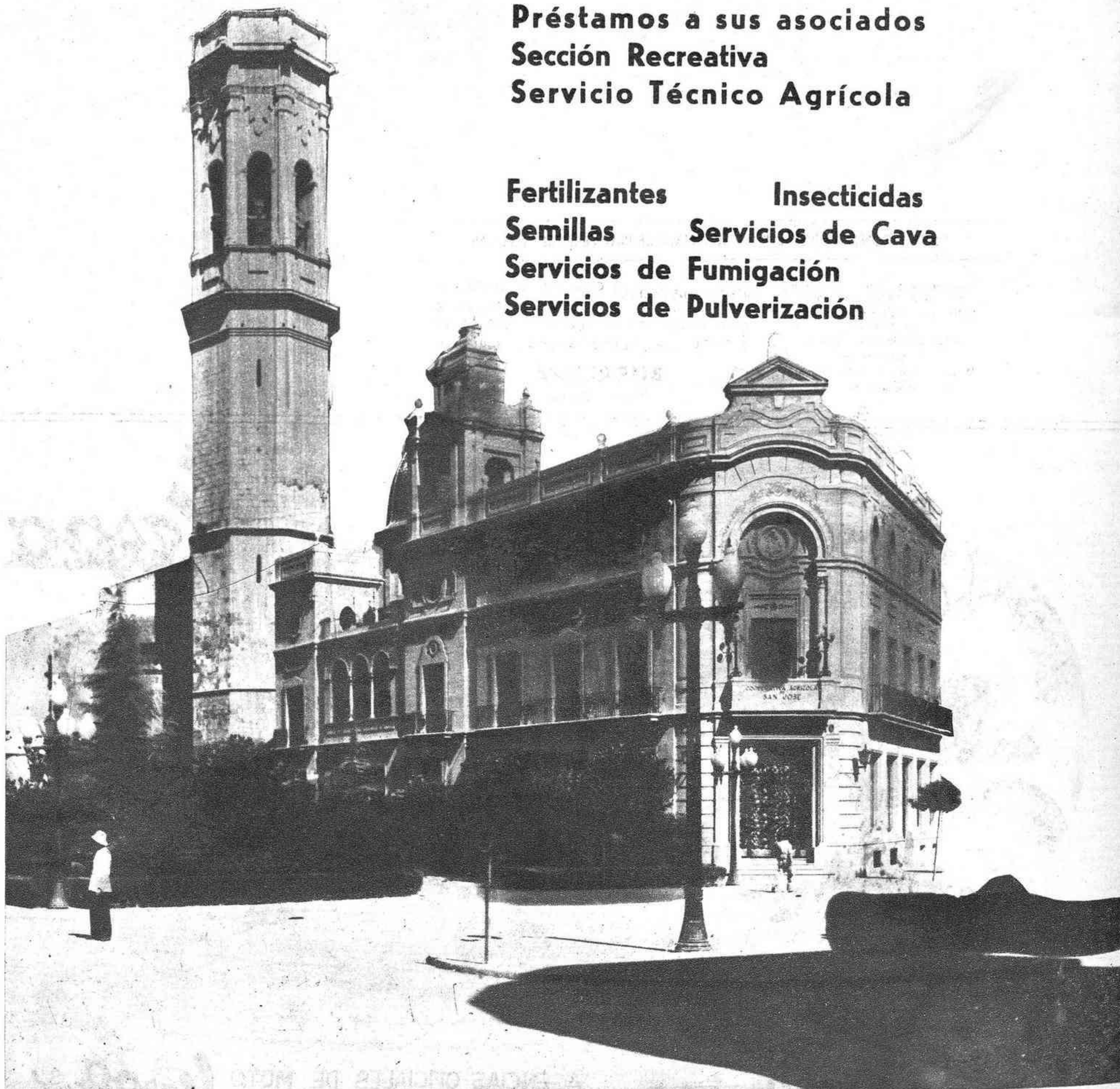
Edificio propiedad de la Cooperativa de Crédito, Caja Rural "San José".
