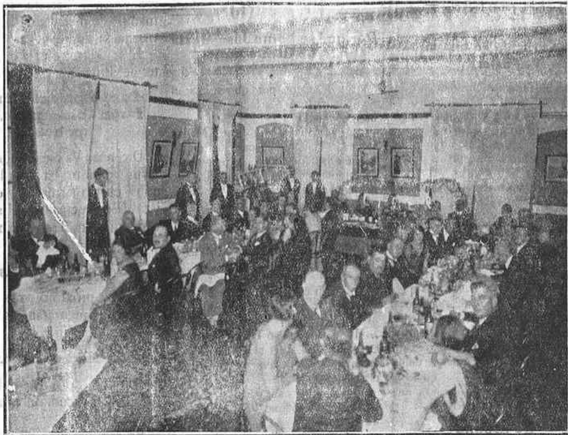
Aspecto del comedor del Quisiana durante el banquete que anoche se celebró para festejar la colocación del primer sillar de la planta eléctrica de la "Cicer".
