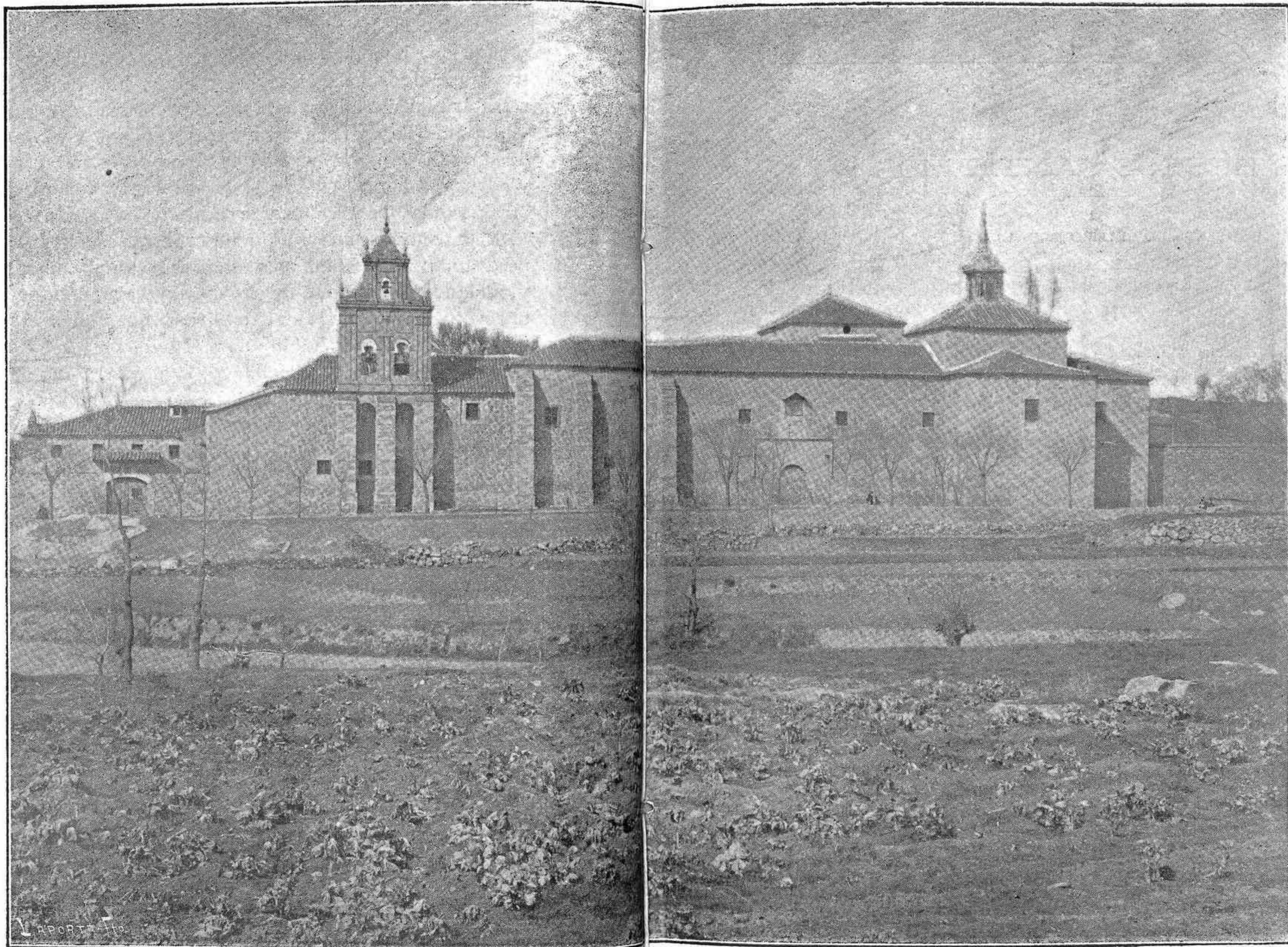
VISTA GENERAL DEL CONVENTO DE LA ENCARNACION
