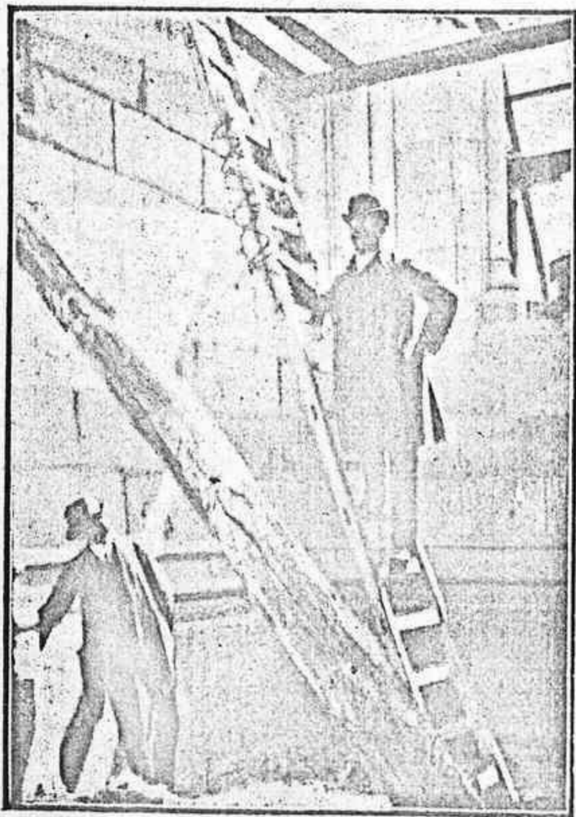
EL SR. REPULLÉS EXAMINANDO LOS TRABAJOS
