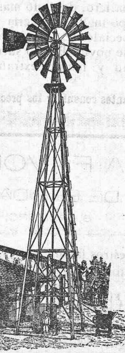
Los de mayor potencia y provistos de dos bombas que operan por medio de balancines, pueden elevar grandes cantidades de agua habiéndose dado el caso de que con un motor de 16 pies se han sacado de un río hasta 80.000 litros por hora cerca de 2.000 metros cúbicos por día. Con un buen estanque que embalse el agua que pueda sacarse aprovechando todos los vientos, se hace fértil el más árido desierto y puede asegurarse no hay empresa más productiva con relación á su costo.
