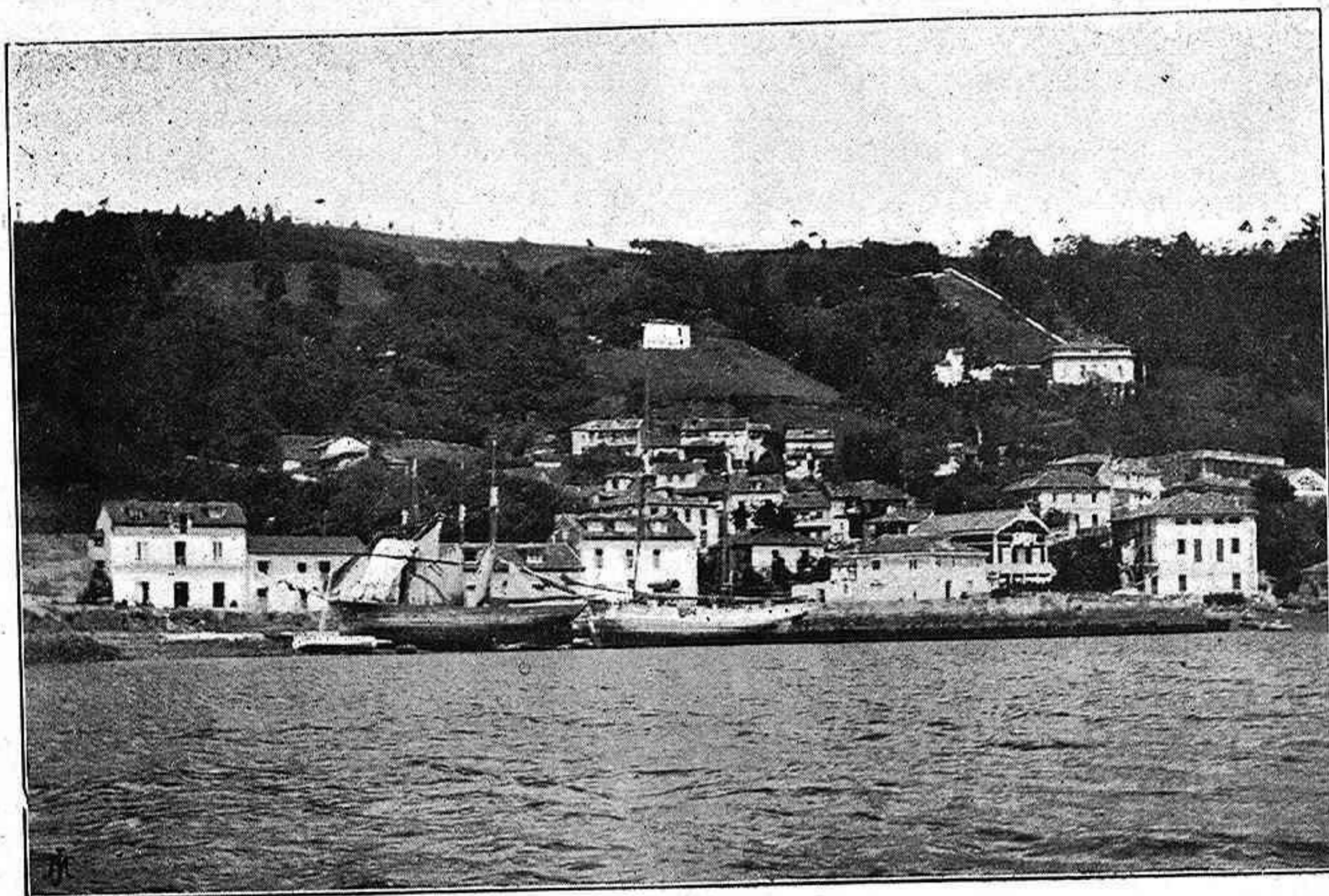
Orillas del Nalón. San Esteban (MUROS)
