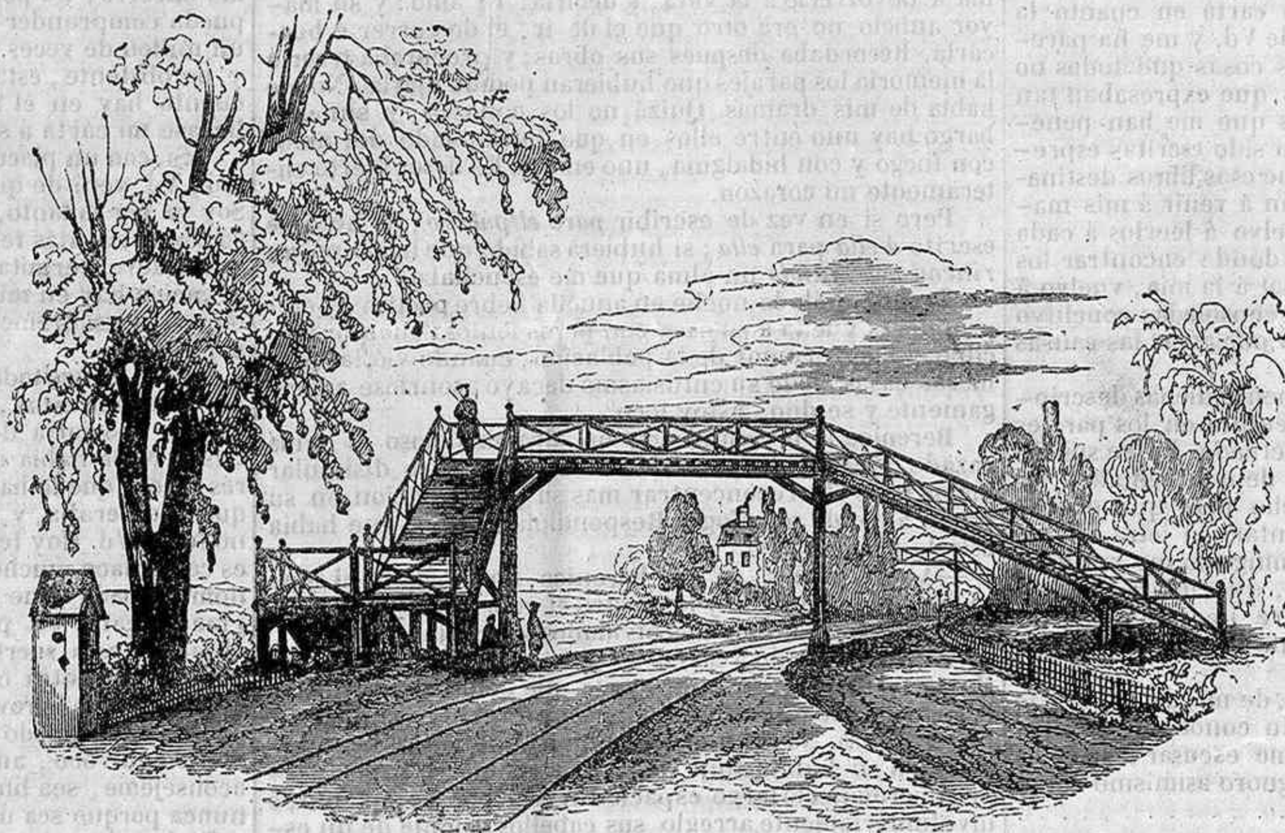
Travesía para personas sobre el camino de hierro.
