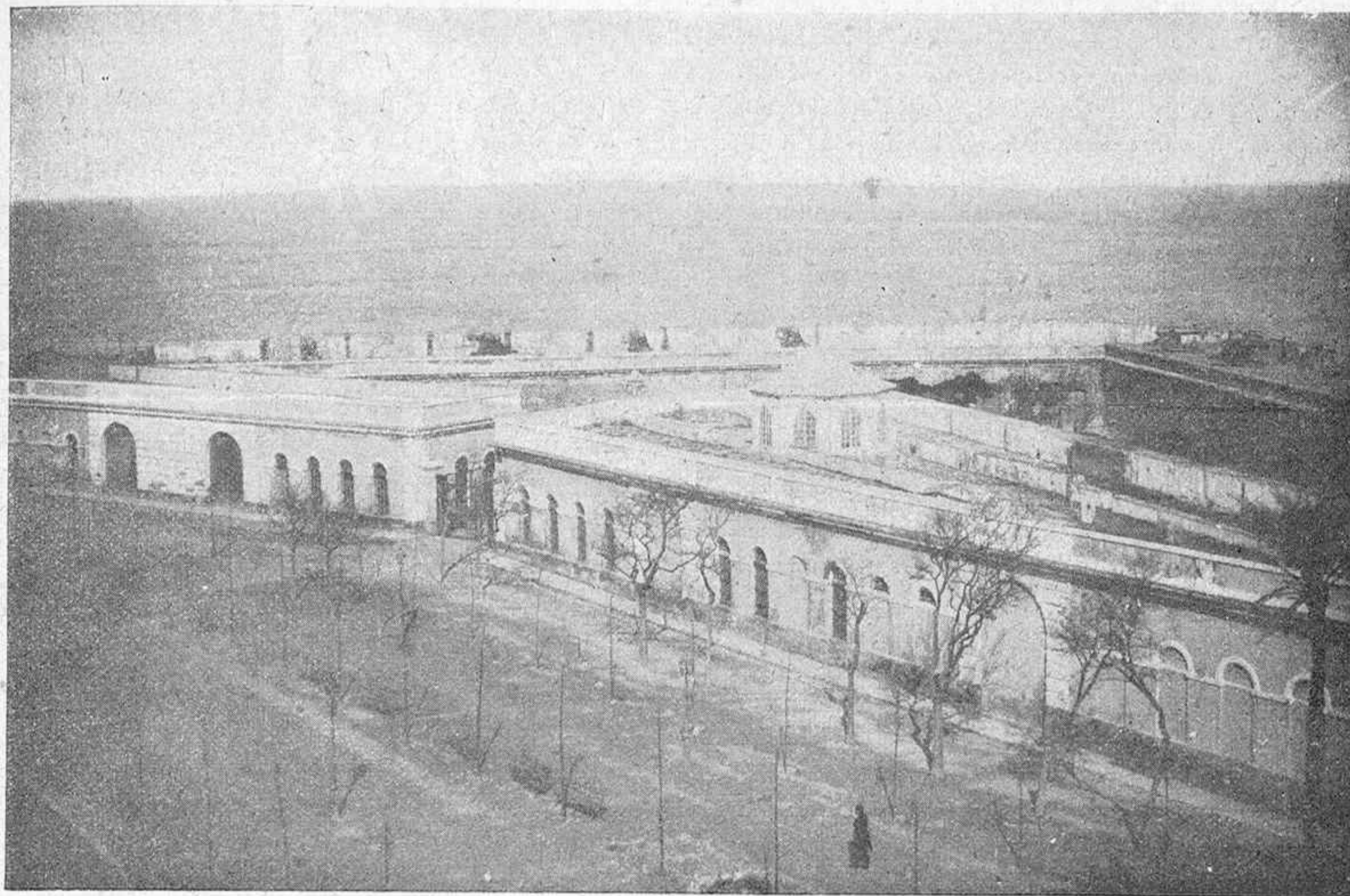
BATERIA DE LA CANDELARIA.—Al Oeste de la segunda línea se hallan además del baluarte de la Candelaria, la batería de Bilbao y el baluarte del Bonete, que enlazan al Castillo de Sta. Catalina, que con el de S. Sebastián, destacado de aquél defiende la llamada puerta de la Caleta.
