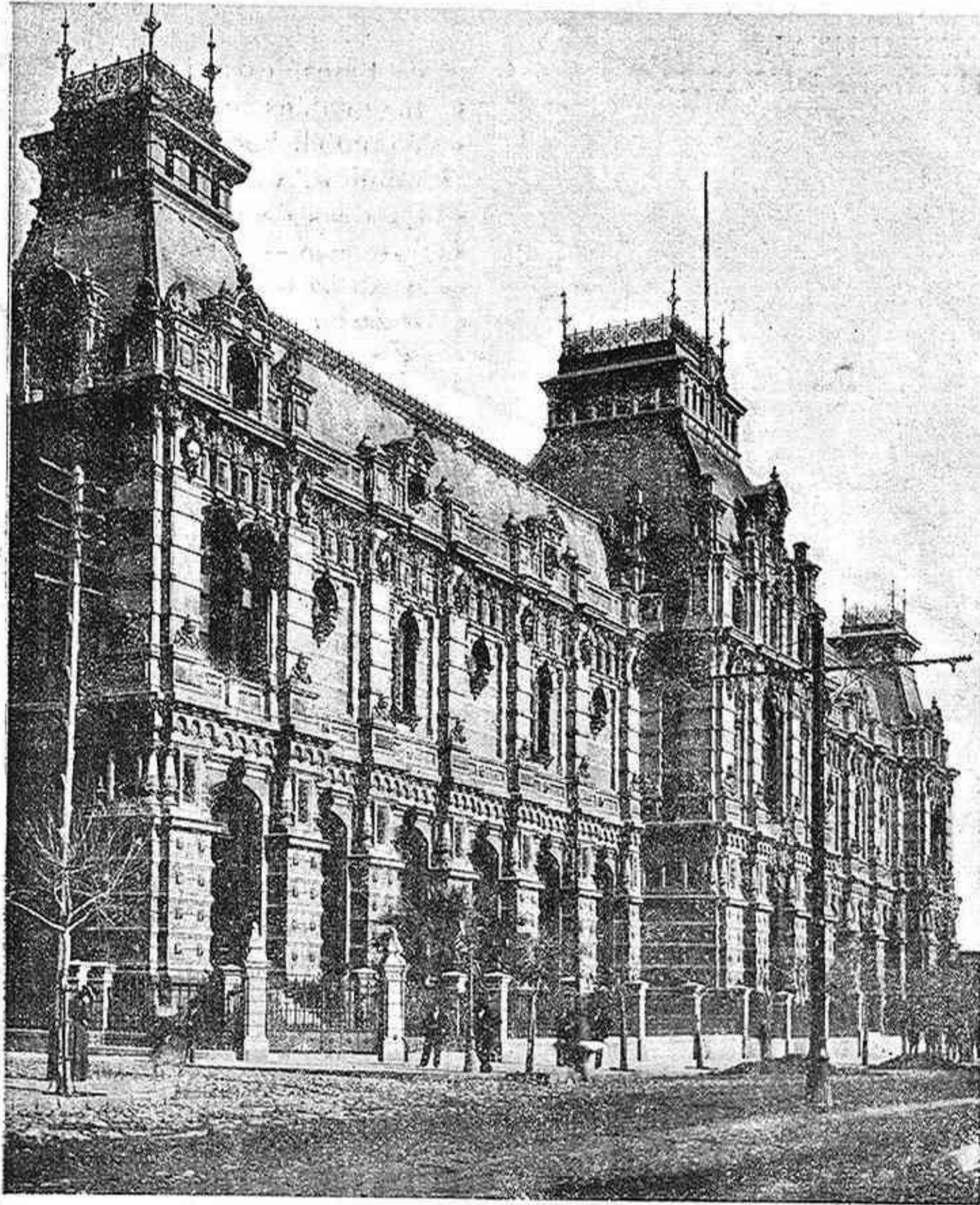
PALACIO DE AGUAS CORRIENTES (DEPÓSITOS) PERSONAJES ARGENTINOS
