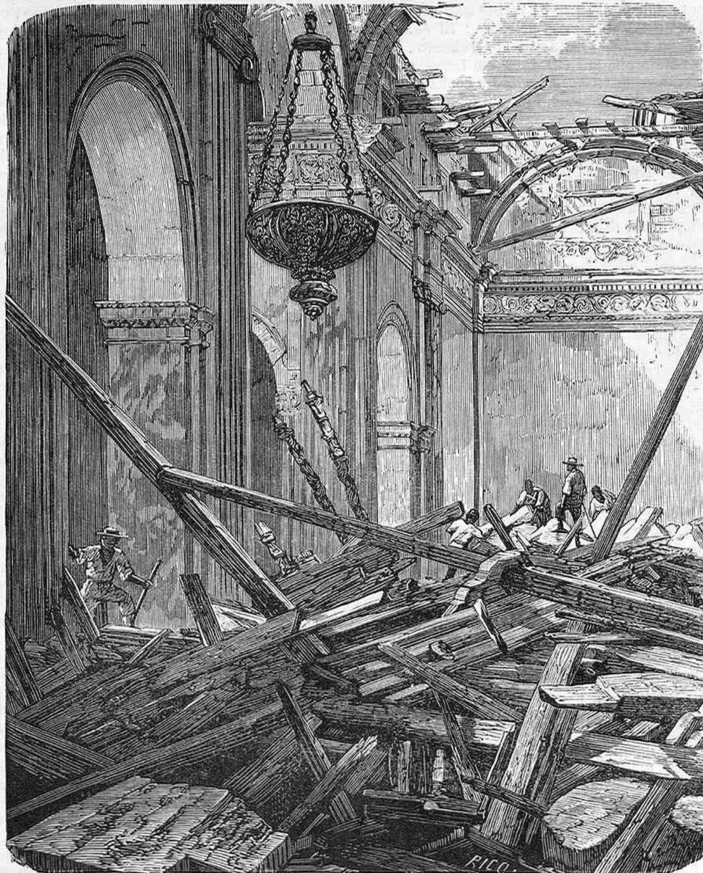
NAVE DE LA CATEDRAL DE MANILA DESPUES DEL TERREMOTO.
