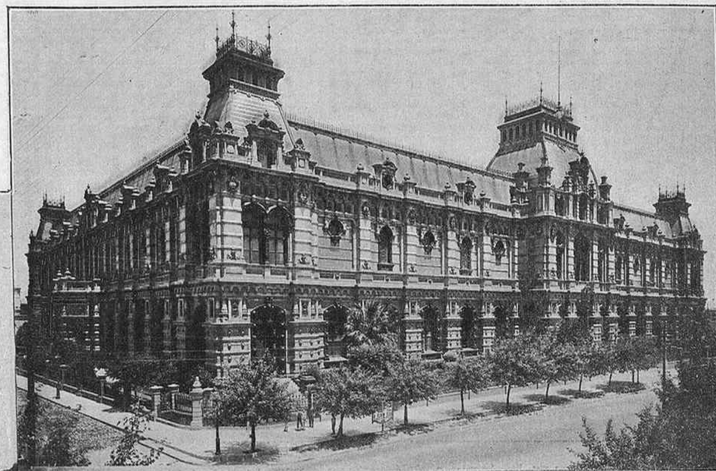
GRAN DEPÓSITO DISTRIBUIDOR. OCUPA TODA LA MANZANA COMPRENDIDA ENTRE LAS CALLES CÓRDOBA, RÍO BAMBA, AYACUCHO Y VIAMONTE.
