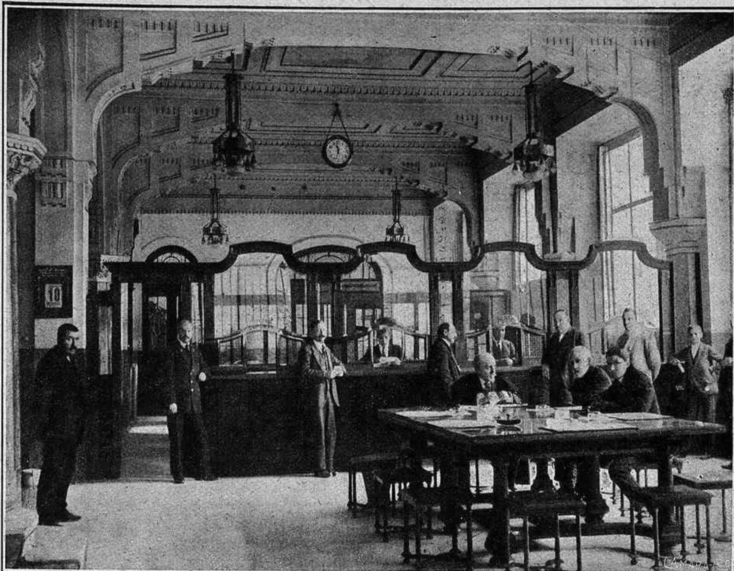
Oficinas del Banco Herrero, de Oviedo, destinadas a operaciones de giros, cuentas corrientes, cupones, títulos, etc
