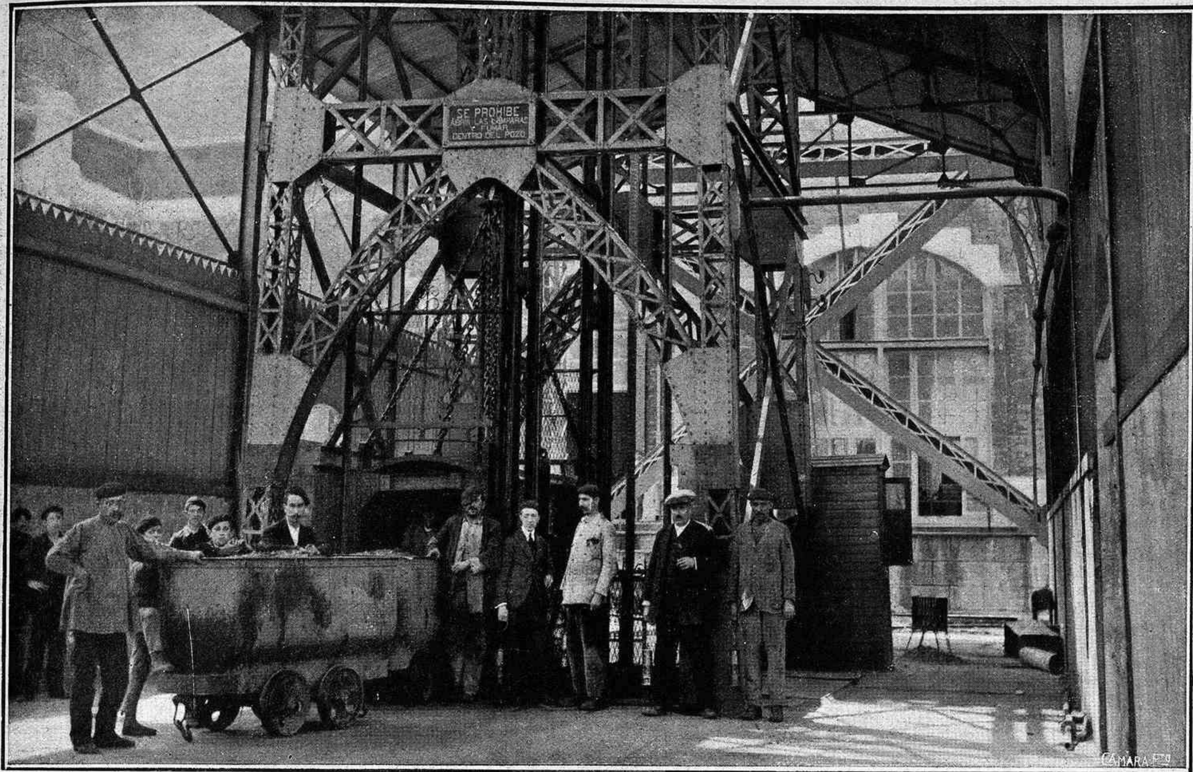
Sociedad metalúrgica "Duro-Felguera". Boca del pozo de extracción de "La Nalona", y jaula en que se elevan los vagones cargados de carbón
