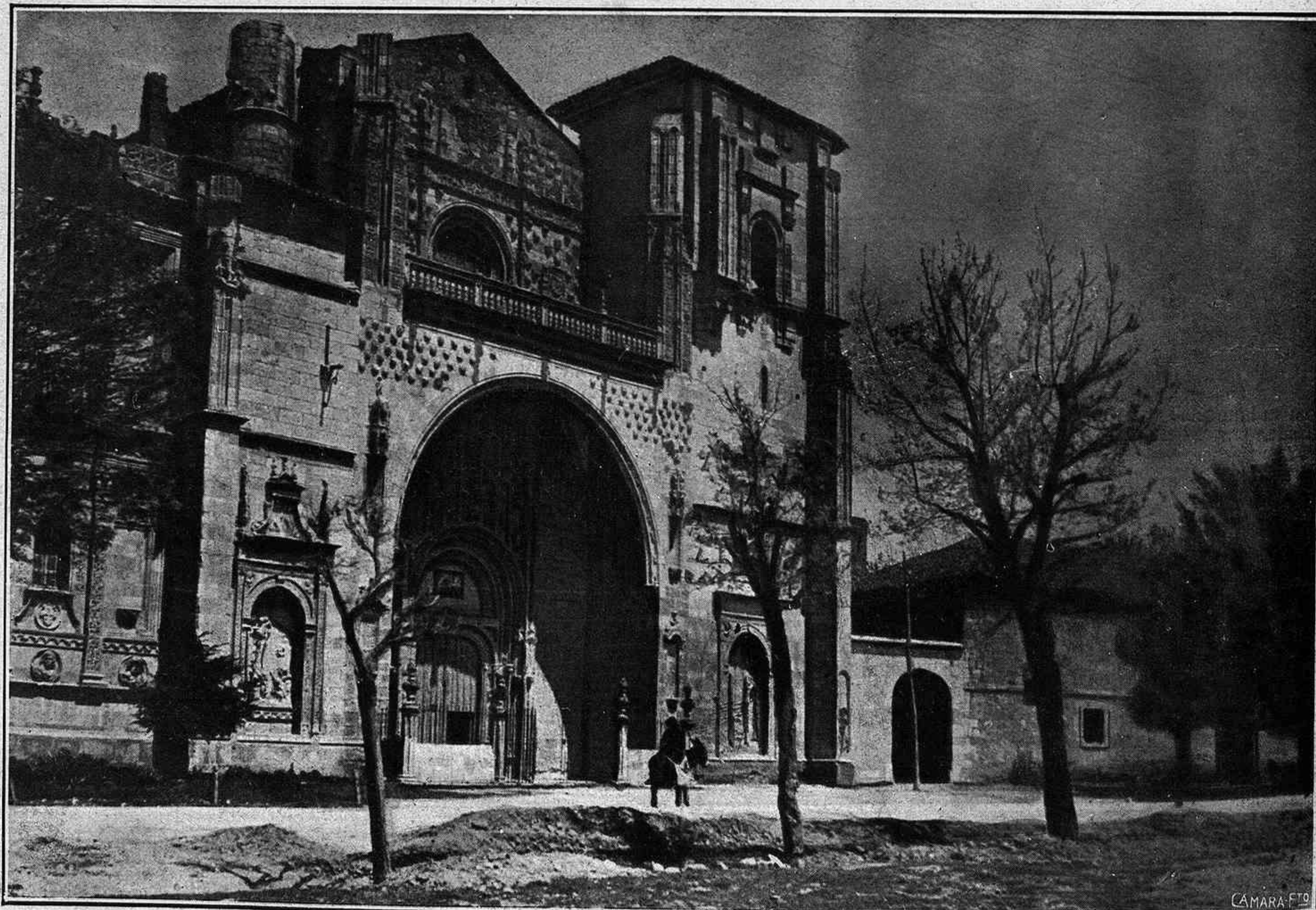
Fachada de la iglesia de San Marcos, de León, edificada hacia el final del siglo XI y reedificada en 1514 por Fernando el Católico FOT. SOL
