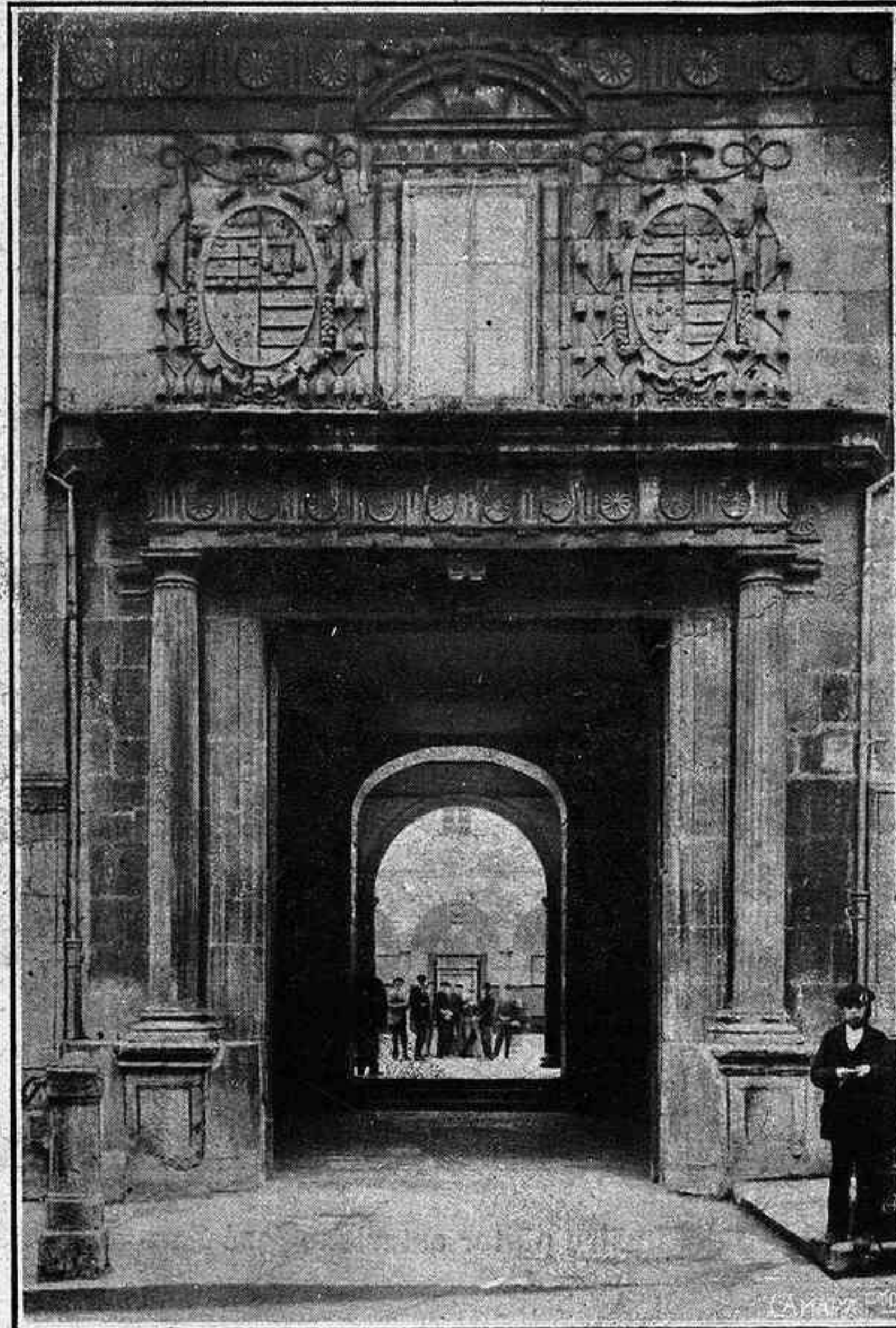
Puerta principal de la Universidad, de estilo dórico, en su fachada Norte
