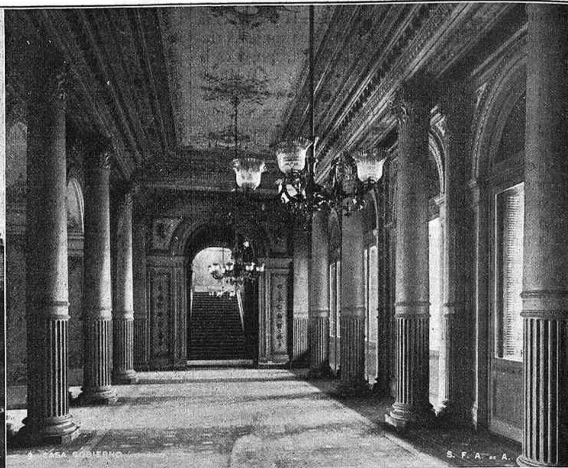
VESTÍBULO DEL ALA NORTE
