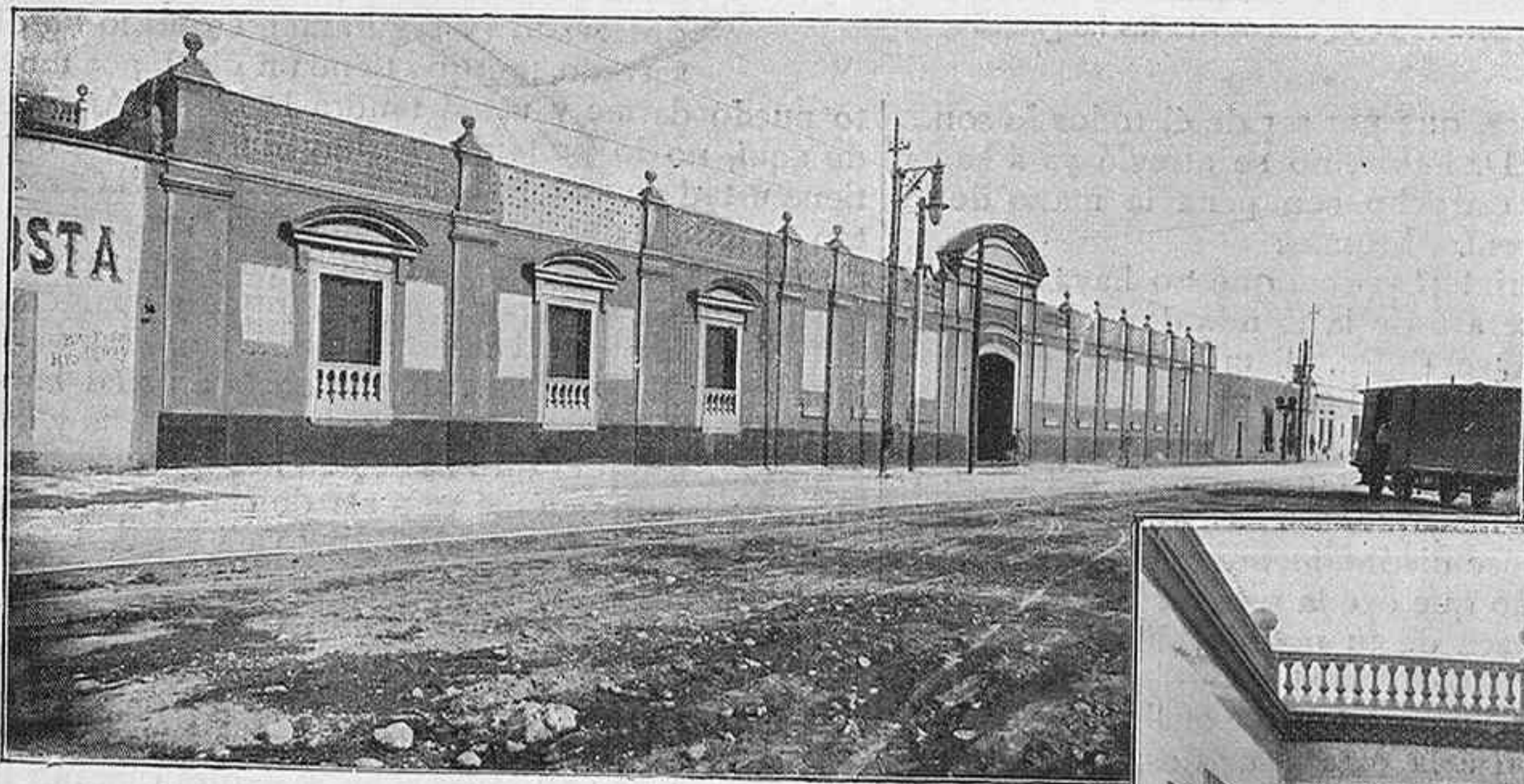
MÉXICO. - Fábrica de cementos de Quintana Hermanos. - Fachada
