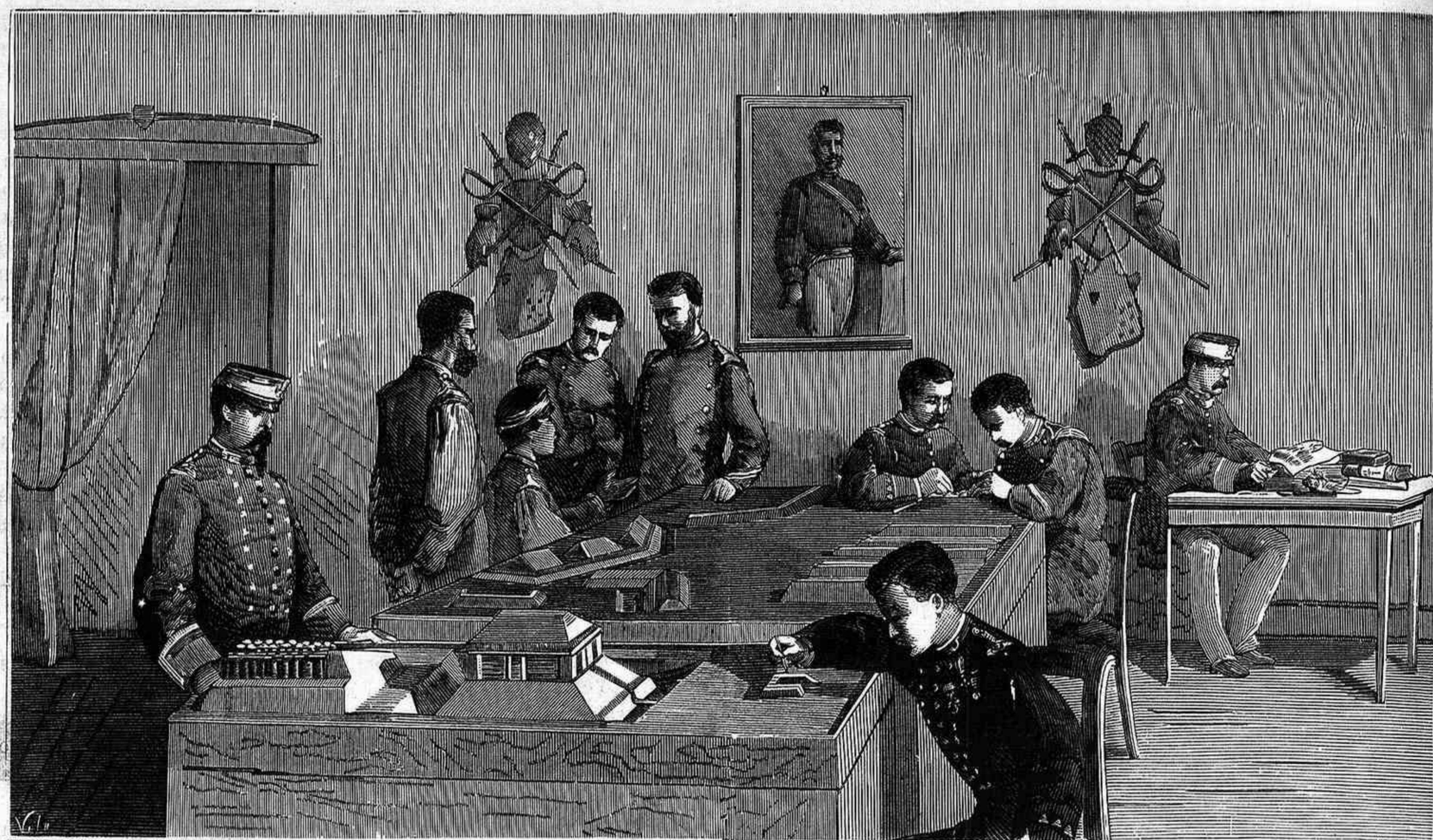
TRABAJOS DE FORTIFICACIÓN.
