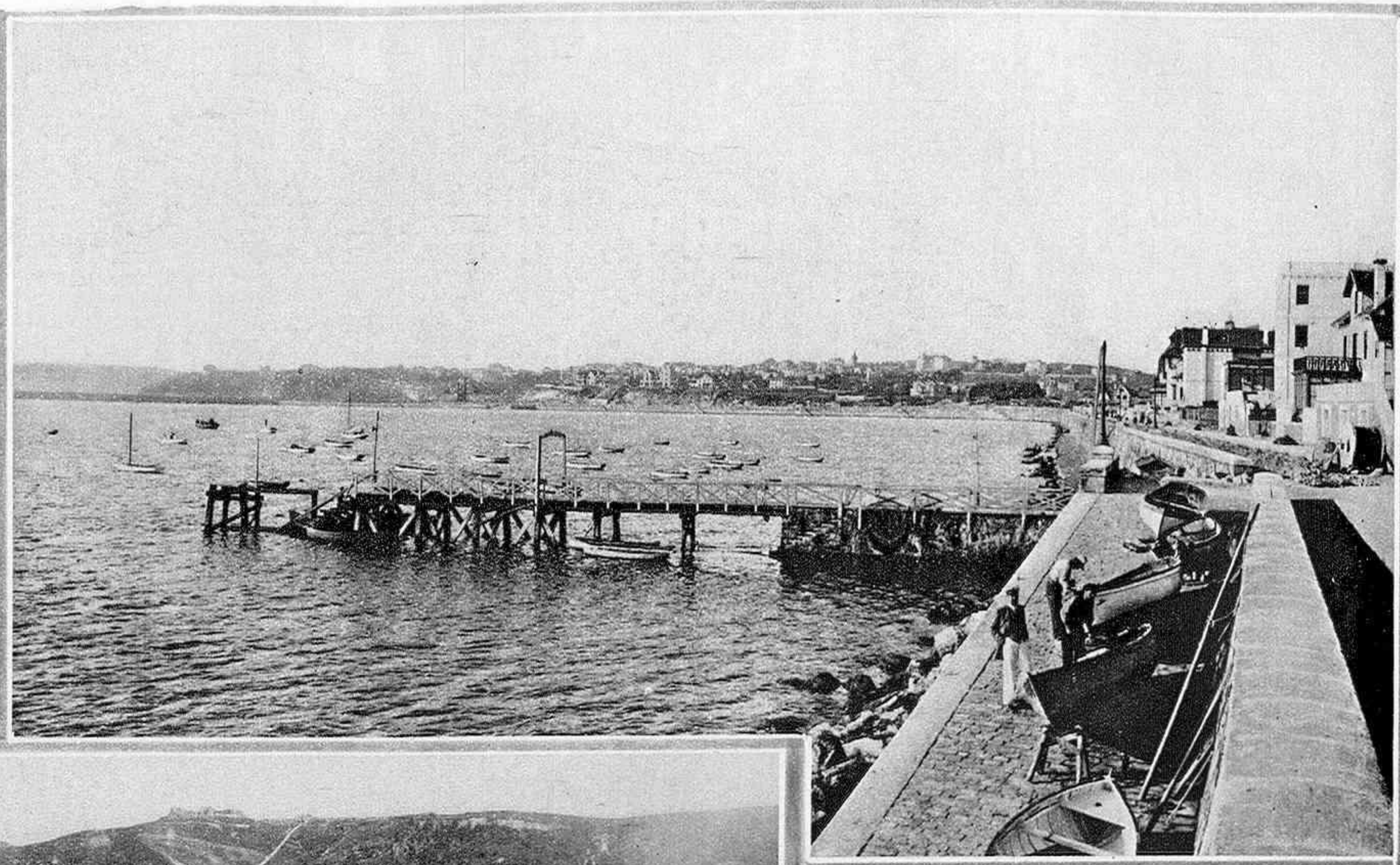
El muelle de las Arenas, en Bilbao
