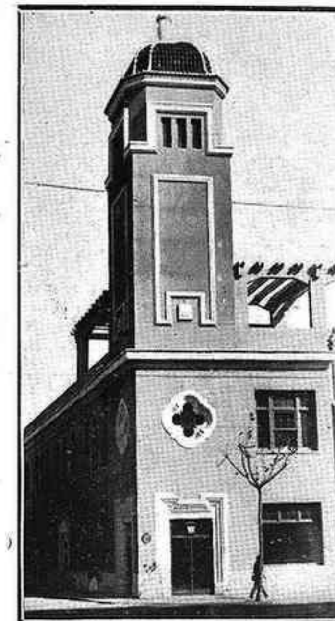
Edificio construido en el Grao para Central automática
