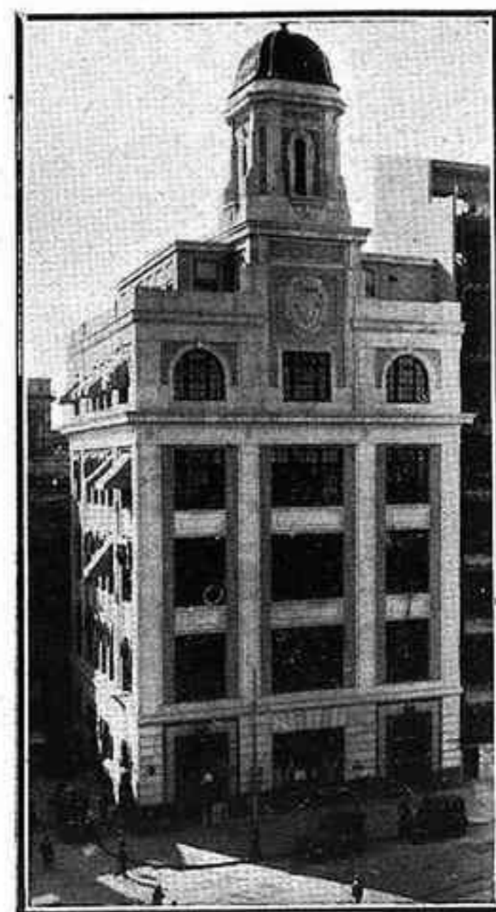
Edificio construido en Valencia para oficinas generales y Central automática
