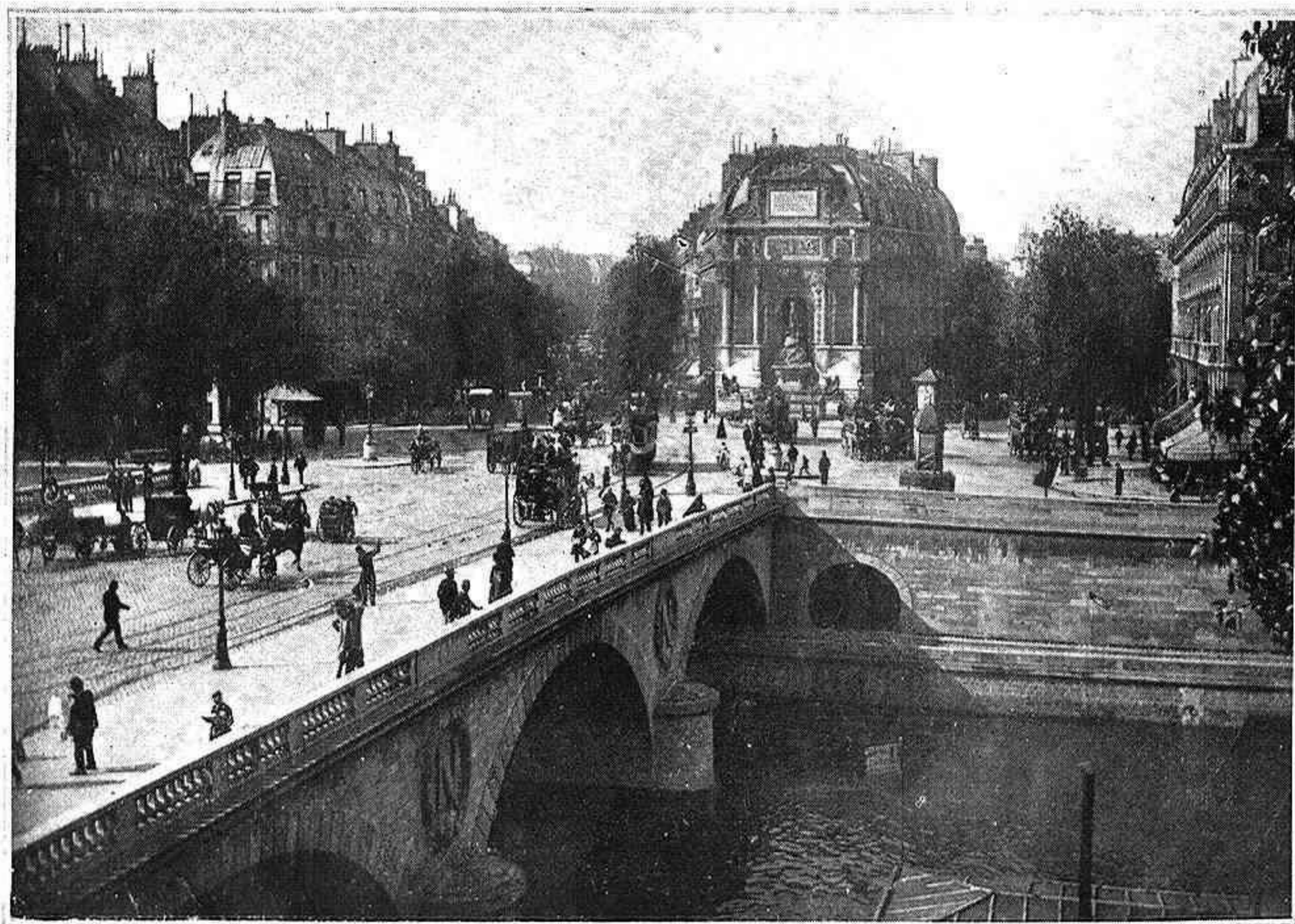
El puente, la plaza y la fuente de Saint Michel, actualmente
