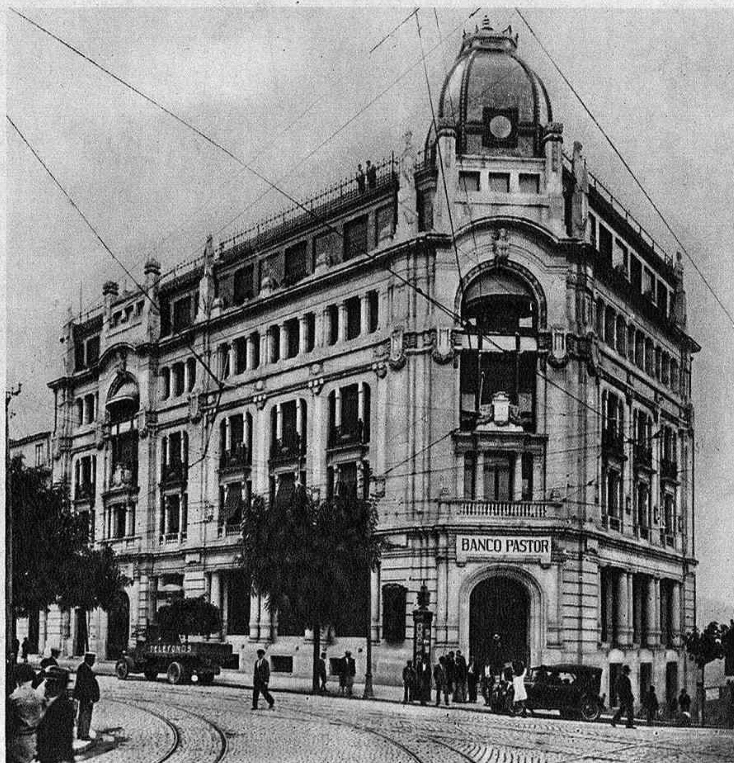
Edificio moderno del Banco Pastor, de Vigo
