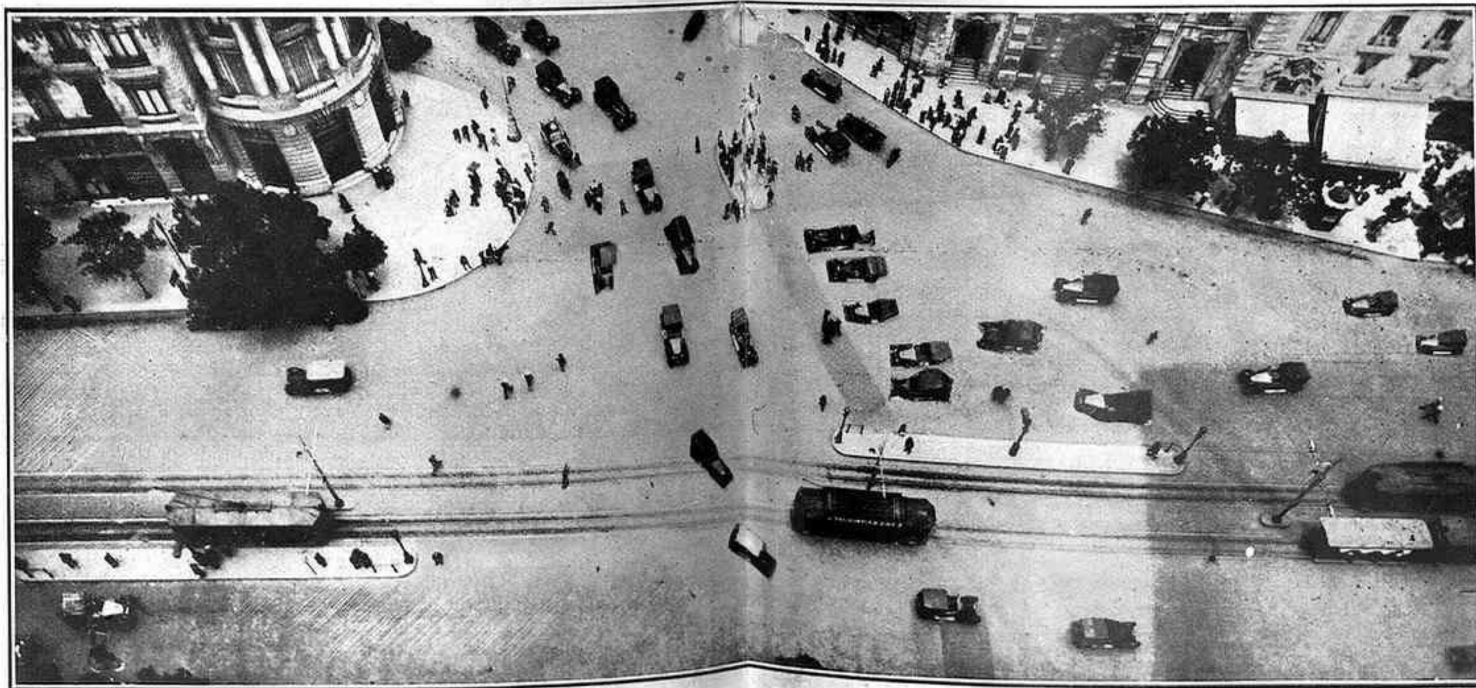
Aspecto que ofrece el entronque de la calle de Alcalá y de la Gran Vía desde lo alto del nuevo edificio del Círculo de Bellas Artes (Notabilísimas fotografías obtenidas por Cámara)
