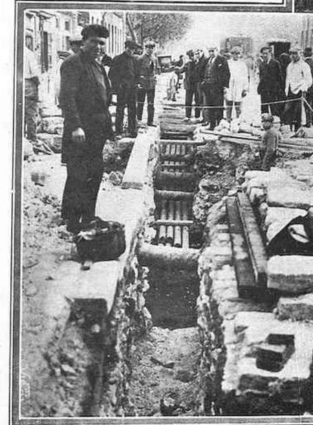
Valencia.—Aspecto de la canalización en sus comienzos. Esta obra está ya casi terminada. Por los conductos de fibra que se ven en el fondo de la zanja se tendieron posteriormente los cables telefónicos
