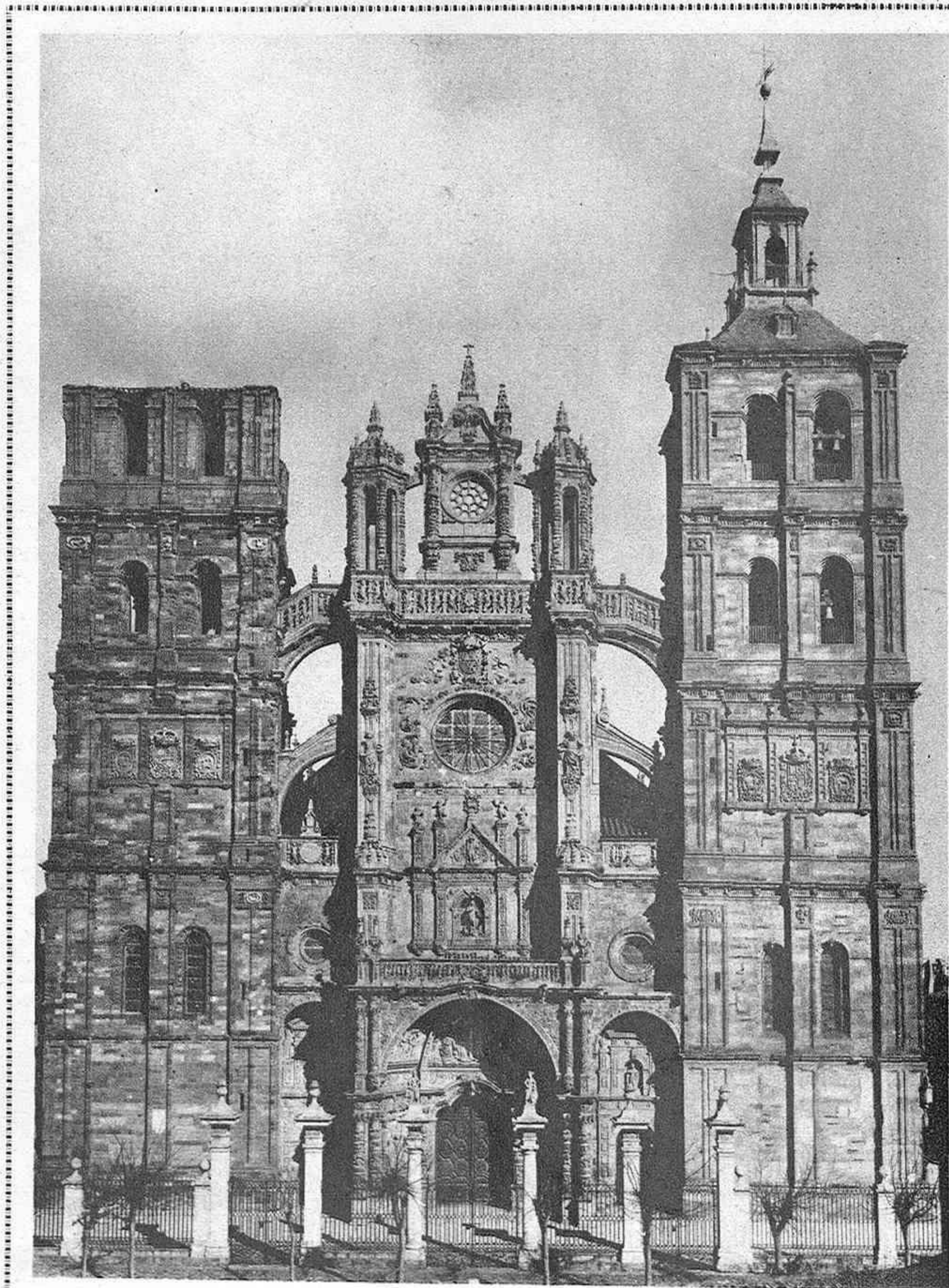
Fachada principal de la Catedral de Astorga
