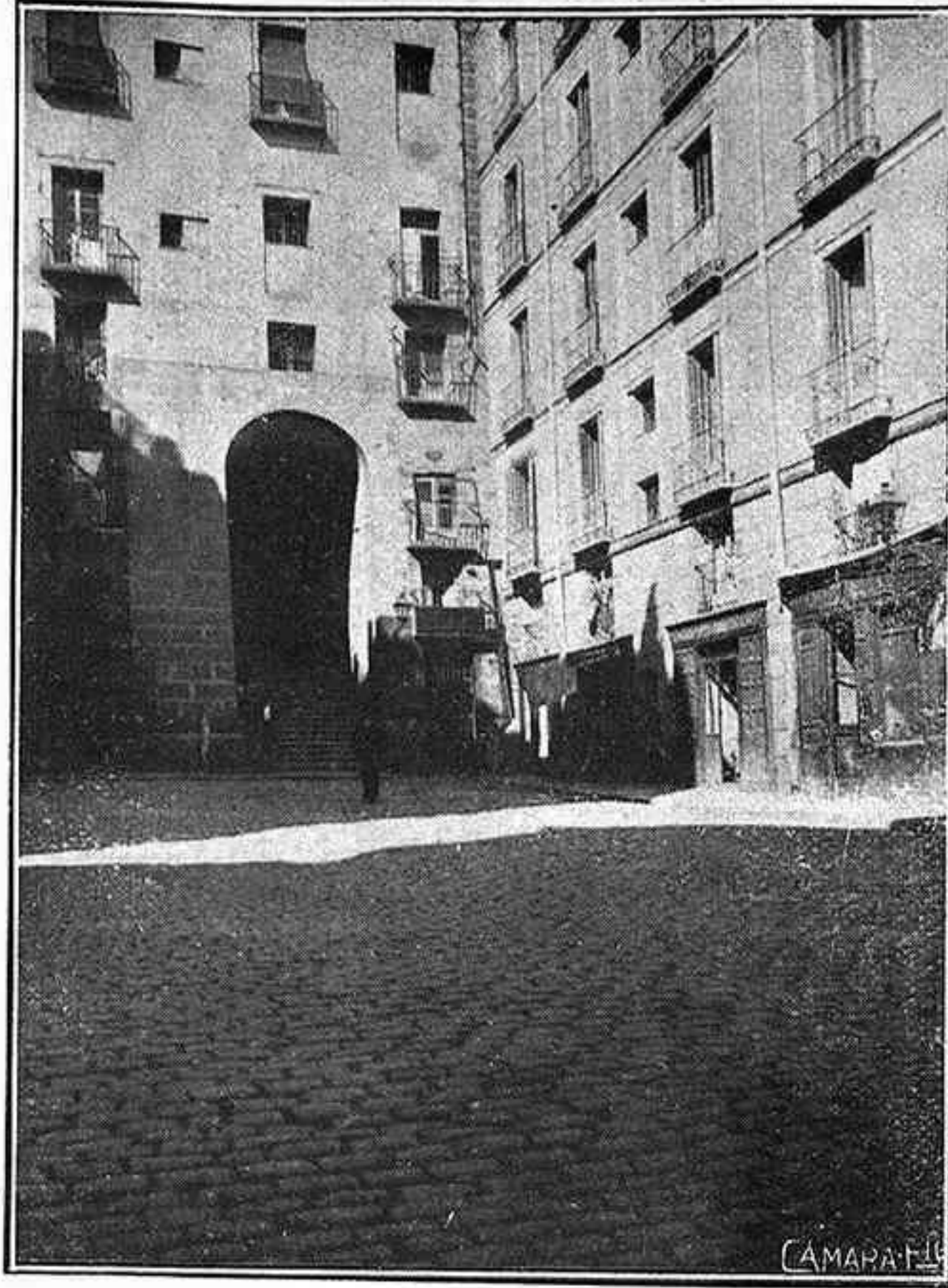
El arco de la escalerilla de la Plaza Mayor á la calle de Cuchilleros
