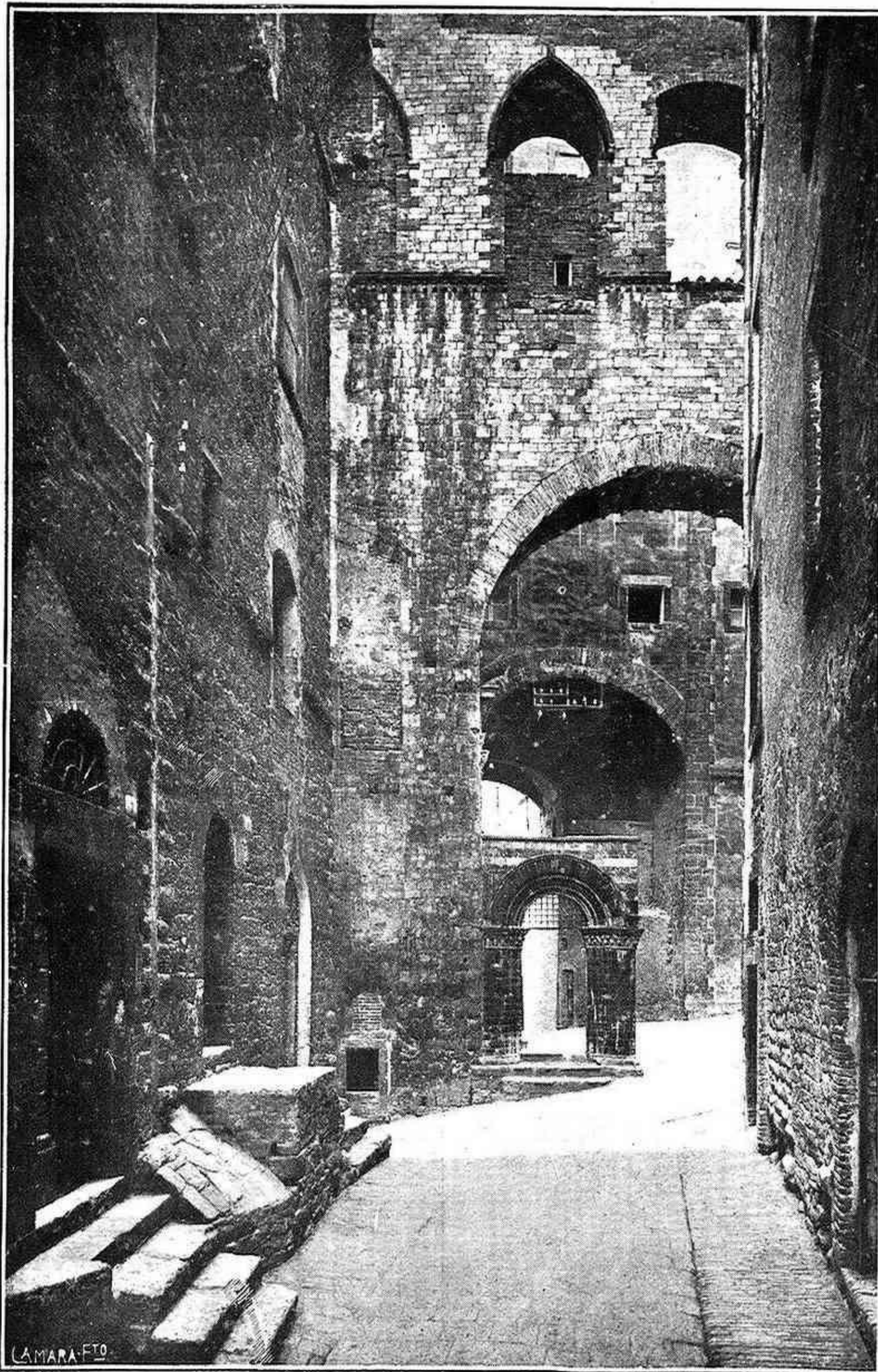
Aspecto de una calle de Perugia. El pórtico del fondo corresponde al Palacio Episcopal, desde el cual Urbano VI excomulgó en 1387 al antipapa Clemente VII de Aviñón, autor del cisma de Occidente
