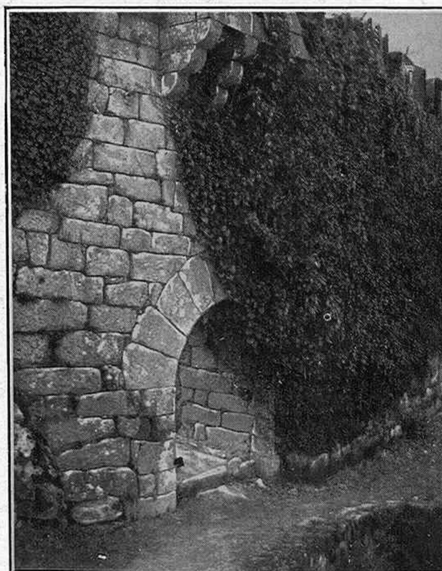
Antiquísima entrada al recinto exterior
