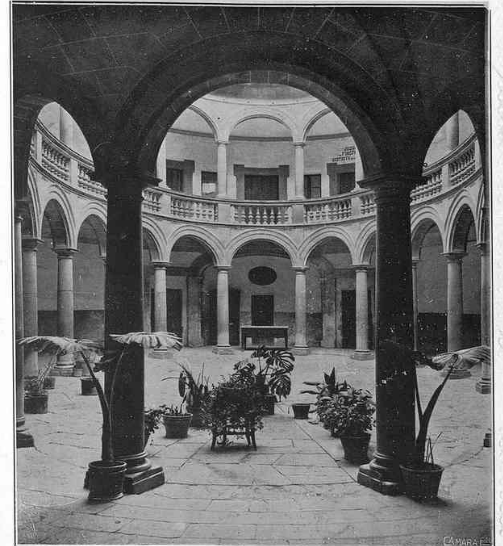
Patio del convento de San Antonio de Viana
