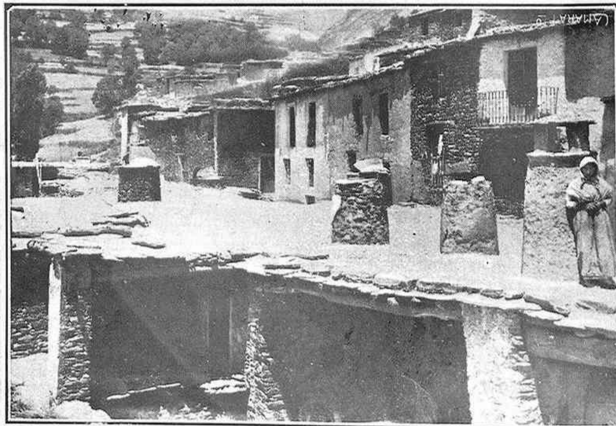
Techos de «launa», que sirven de plaza
