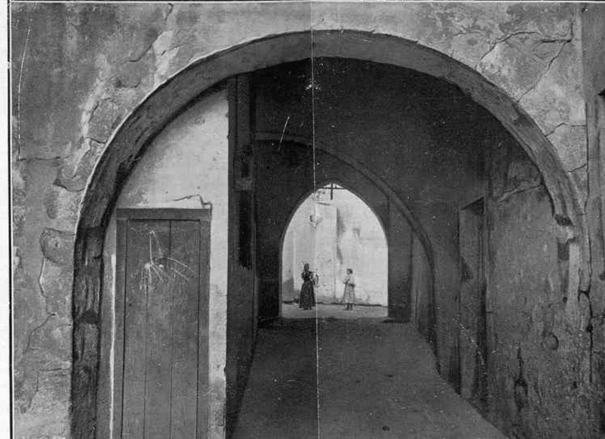
Una de las calles que aún se conservan en el recinto de la antigua iglesia
