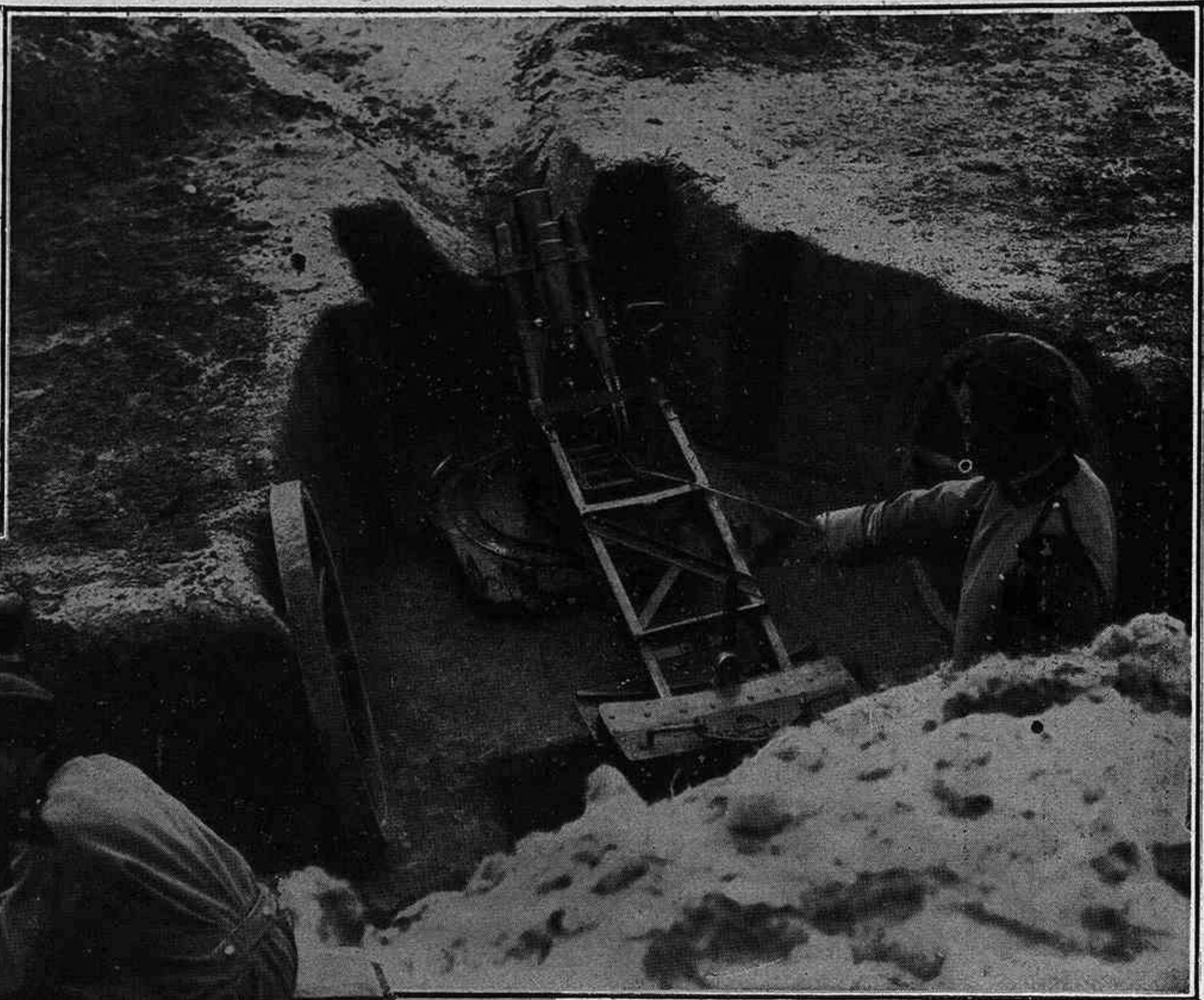
Un mortero de trinchera
