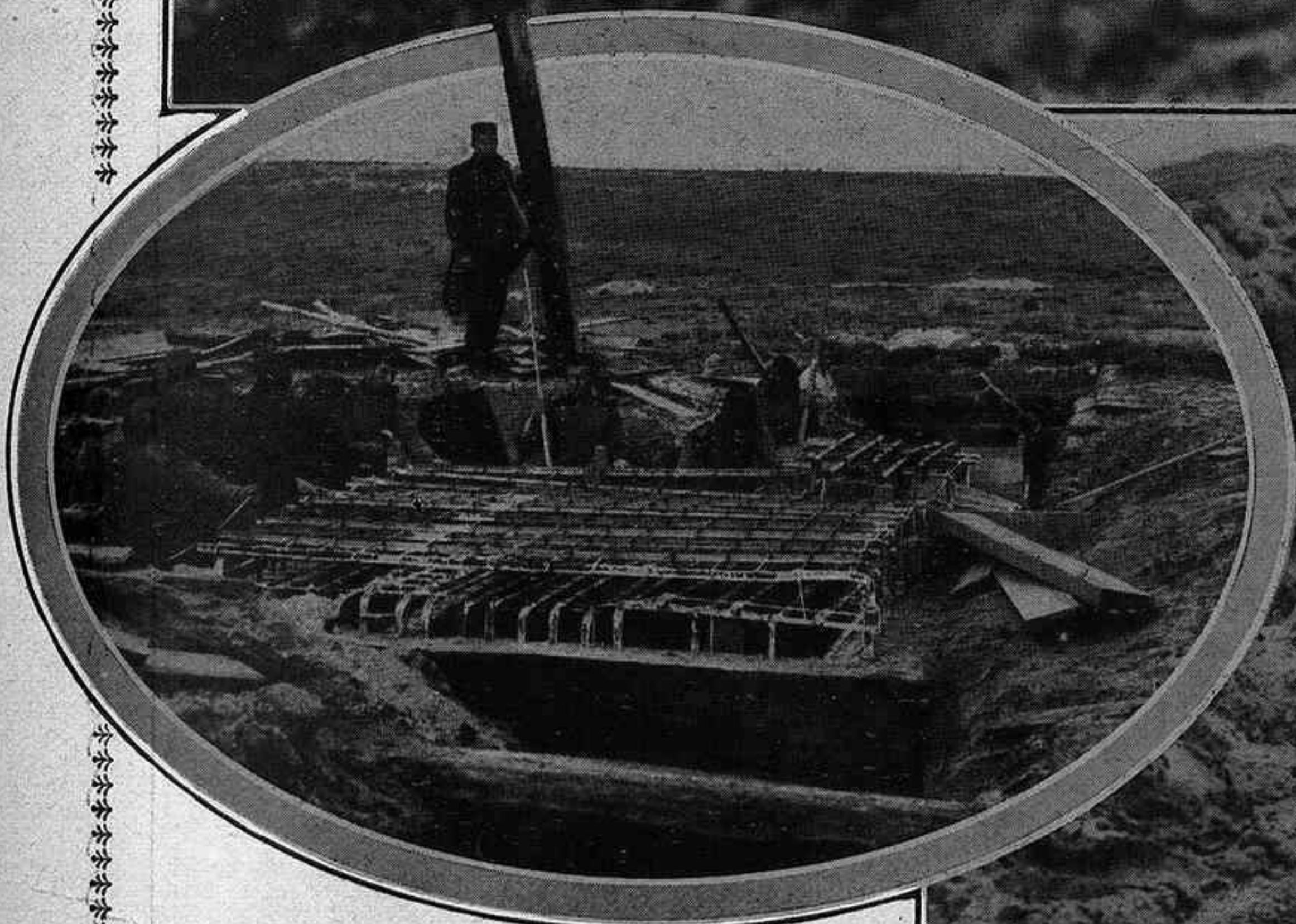
Fusil automático de trinchera.—Construcción de un abrigo de hormigón armado
