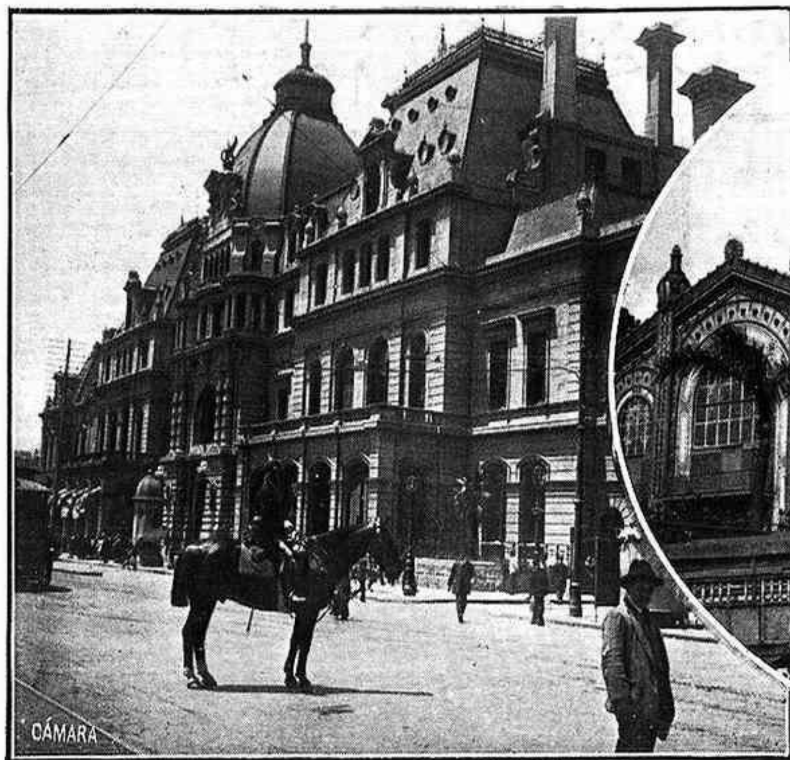
Estación del ferrocarril del Sur
