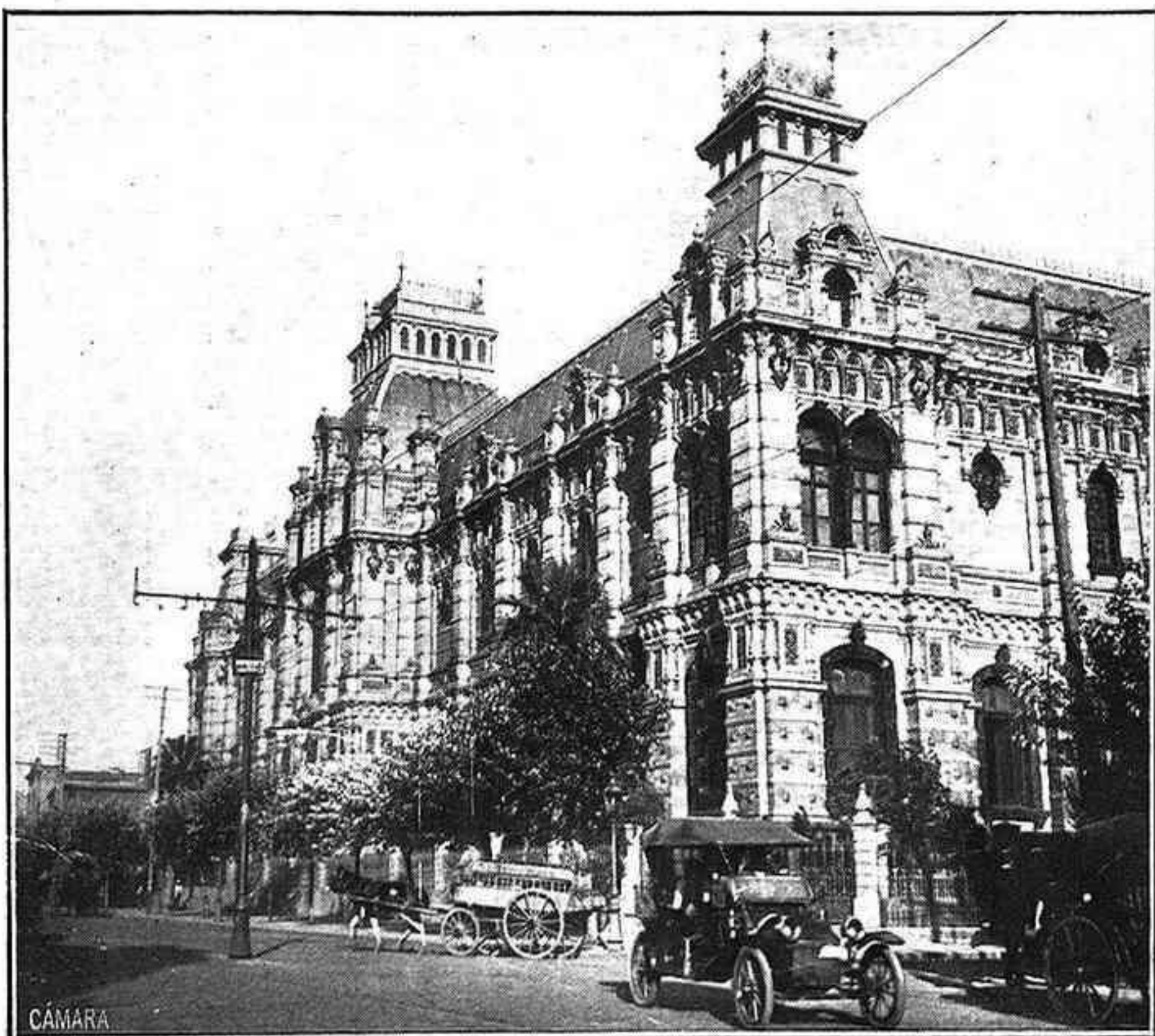
Depósito para el abastecimiento de aguas
