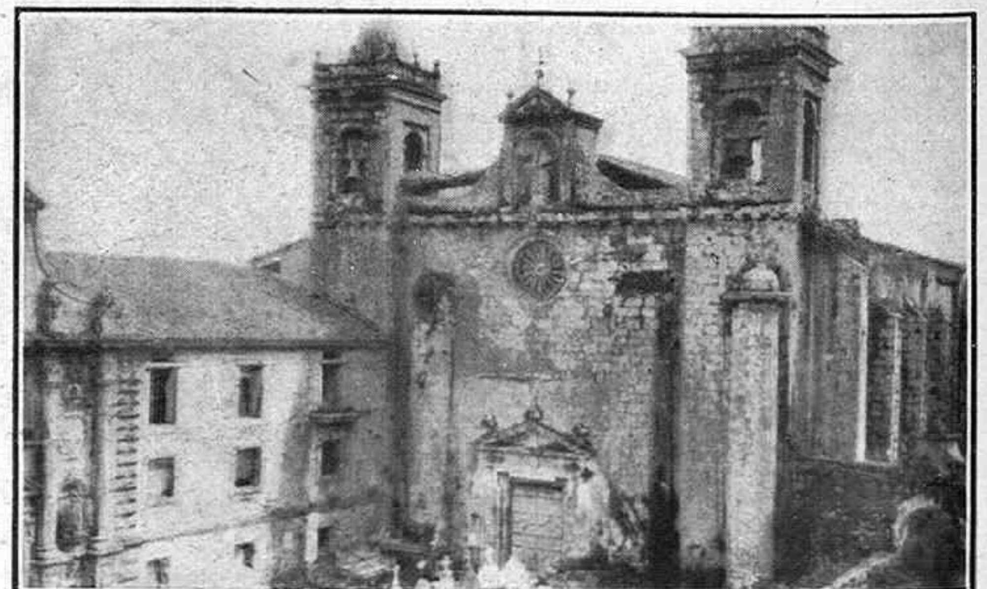
Fachada del convento de Rivas de Sil
