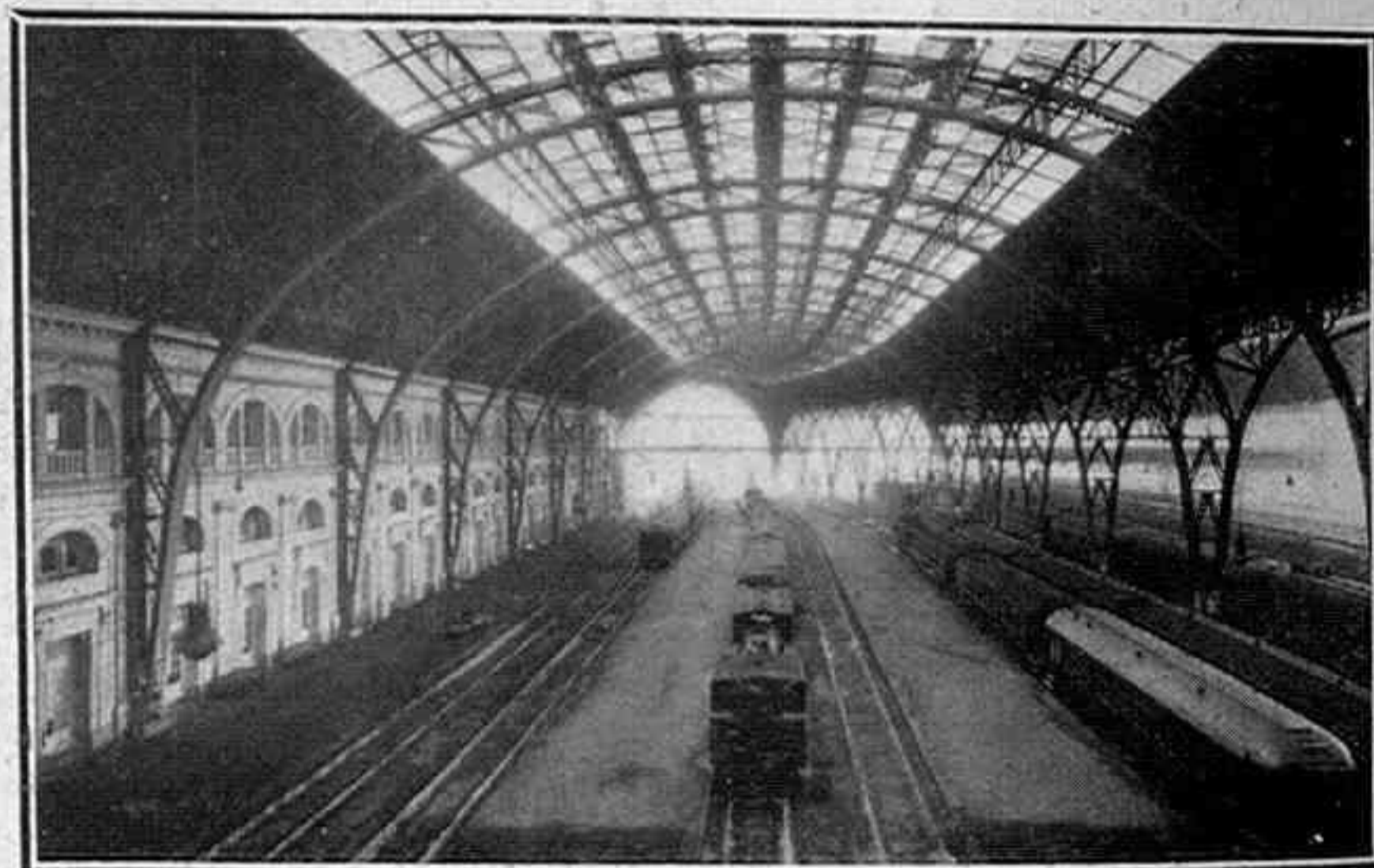
Interior de una de las marquesinas de andenes, donde se observa el trabajo de vidriería que la Casa Cardona ha realizado
